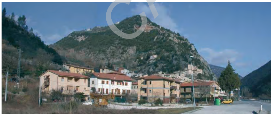
Fig. 30 - Panoramica in località Piedipaterno. Zona di alimentazione della frana di crollo (Versanti sovrapposti all'abitato e alla strada).
