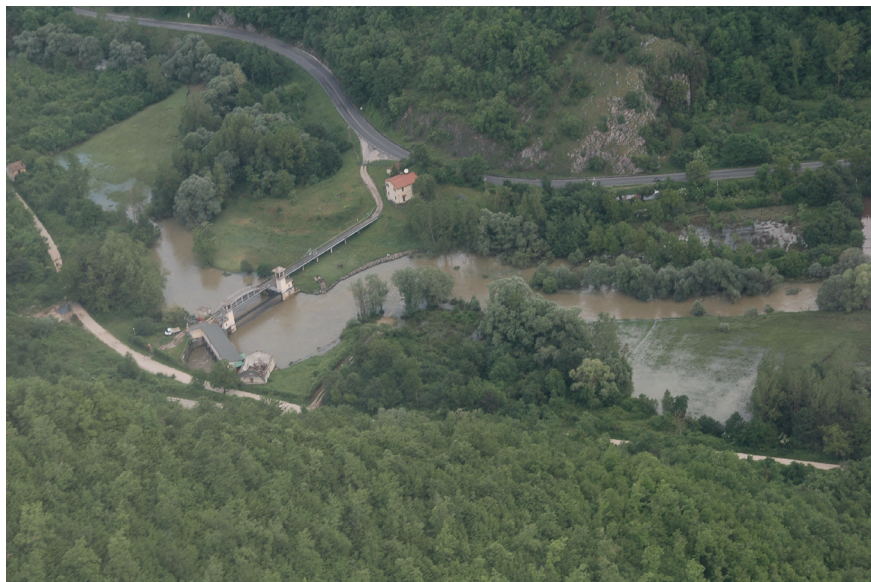
Fig. 33 - La diga di Roviano in occasione della piena del Fiume Aniene nel Maggio 2008 (fonte: Corpo Vigili del Fuoco).
