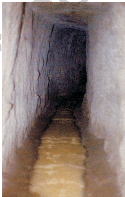
Fig. 56 - Isola di Ponza. Galleria drenante dell'opera di presa.
