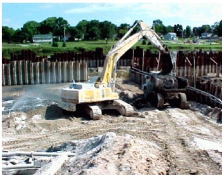
Fig.1 Scavo in area isolata con palandole
