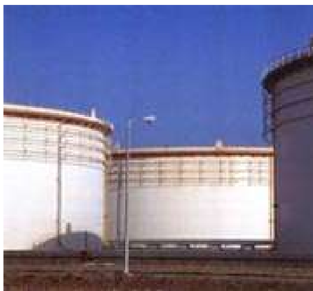
Figura 2: serbatoio a tetto galleggiante
