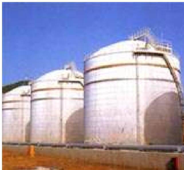
Figura 1: serbatoio a tetto fisso (a cupola)
