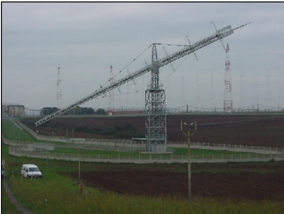
Figura 4 – Antenna log-periodica rotante
