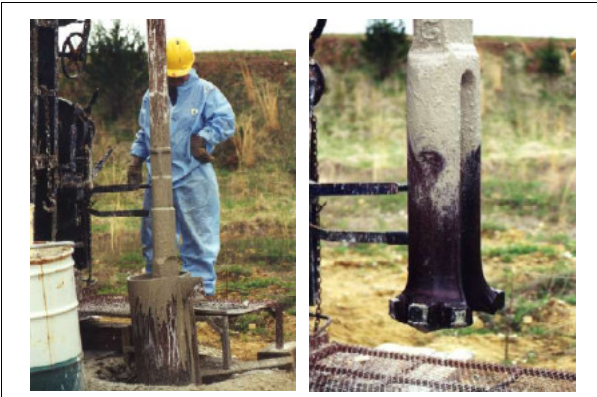
Fig. 27 – Tecnica di perforazione “Cable tool” (da USGS)
