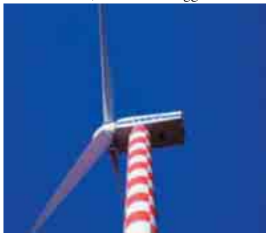
Figura 15. Aerogeneratore. La navicella
