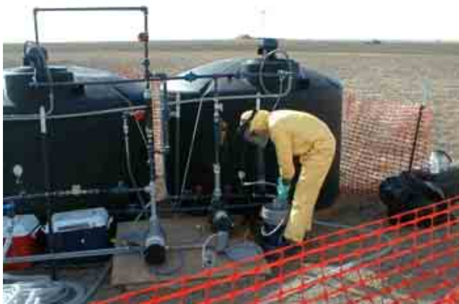
Fig. 8.3 – Operazioni di miscelazione del \text{KMnO}_4 . 167
