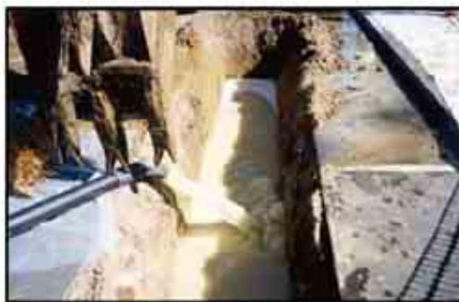
Fig. 4.7 – Immissione di fango biodegradabile (gomma guar) nello scavo della trincea. 31
