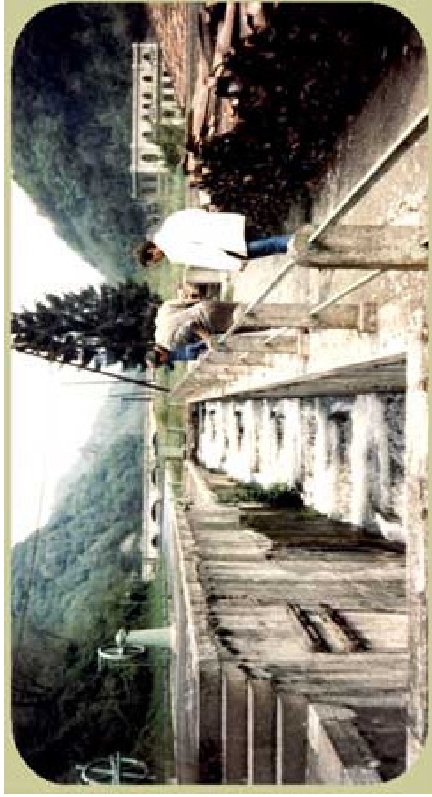
Figura 12: Passaggio a bacini successivi del 1893 sul fiume Adda
