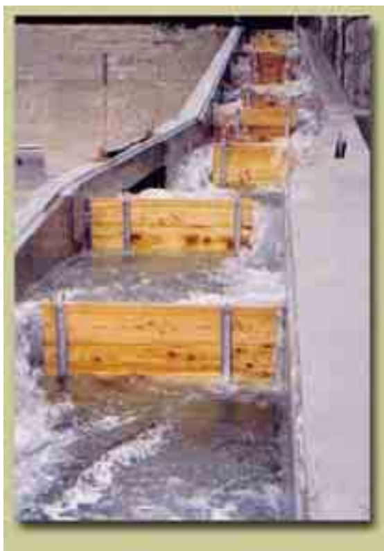
Figura 14: Passaggio a bacini successivi comunicanti tramite orifizio sul fondo e fenditure laterali presente sullo sbarramento idroelettrico sul fiume Piave, in località Soverzene (Belluno), con ittiofauna prevalentemente costituita da Salmonidi.
