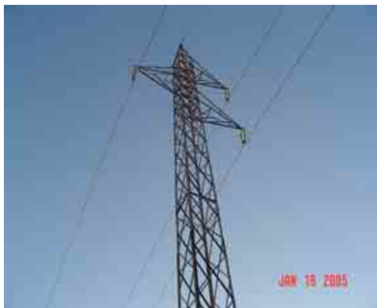
Fig.23 e 24 – Esempio della Geometria di un sostegno a pino – 1, 2 ,3 conduttori delle fase 1 fase A, 2 fase B, 3 fase C. Il 4 é il fune di guardia.
