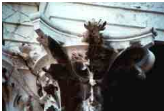
Figura 1. Particolare architettonico in marmo: sono ben visibili le tipologie di danno definite come aree nere e bianche
