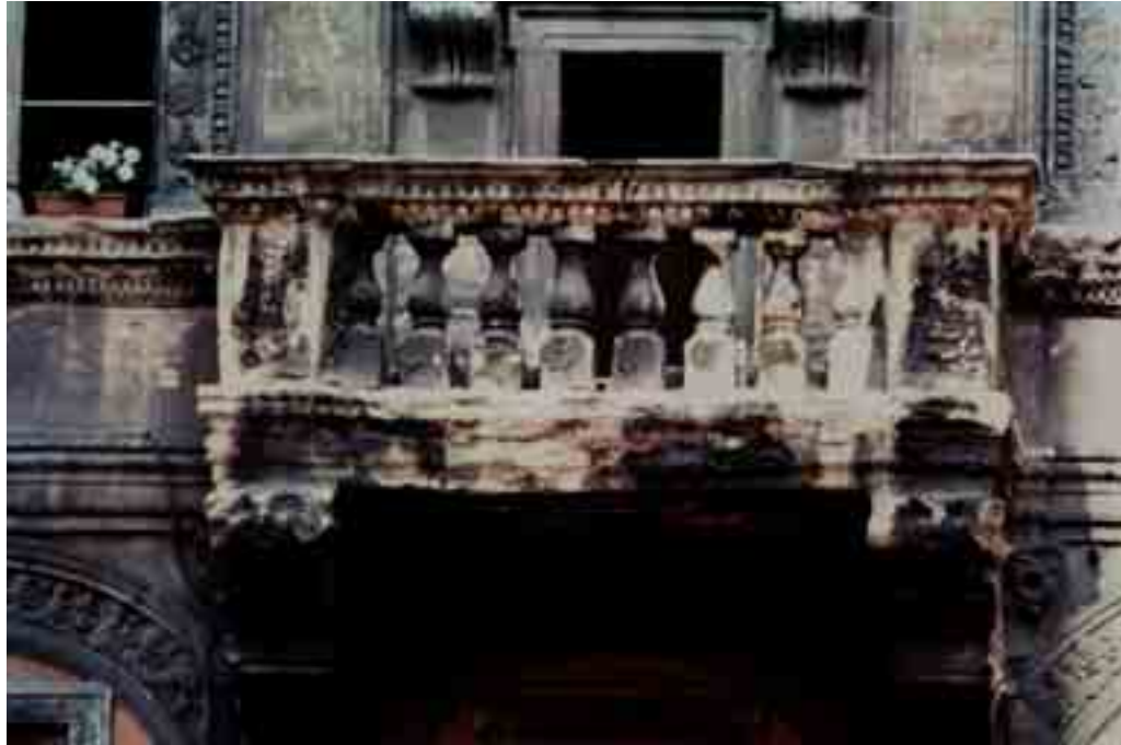
Figura 3. Tipologia di degrado caratteristica delle calcareniti (Bo)
