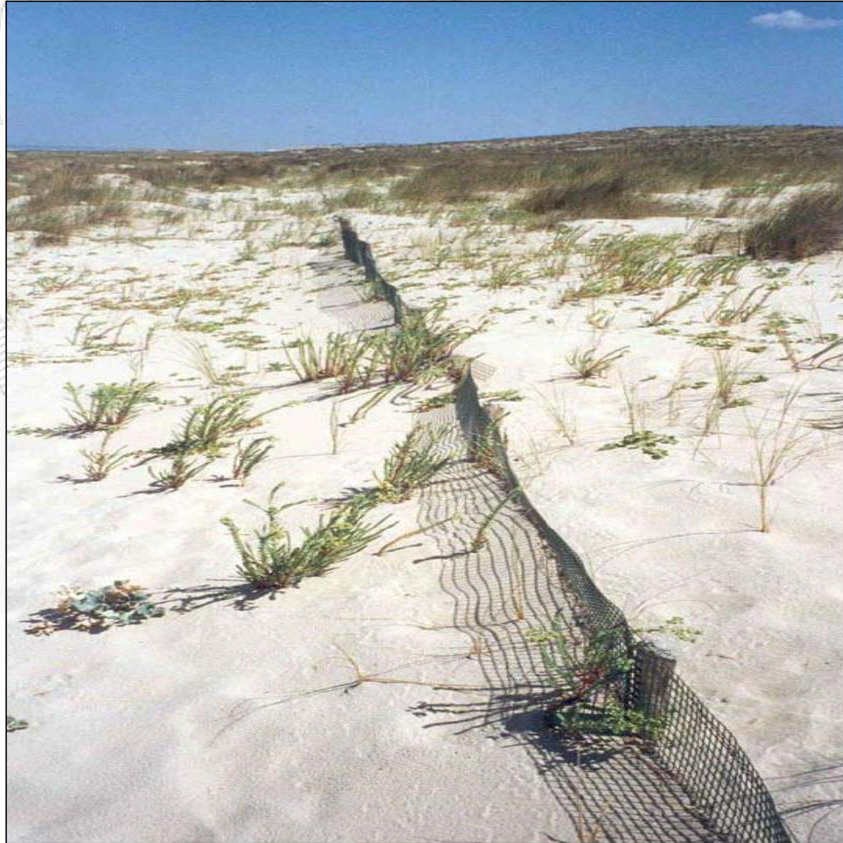
Figura - Reti in geogriglia a protezione di dune mobili a Cape Feret (F) (da DEFRA, 1999)
