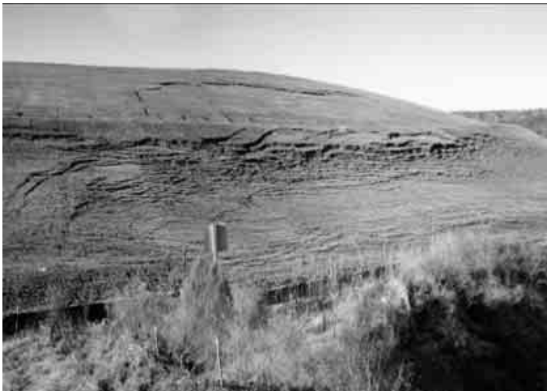
Fig. 3.5 - Foto aerea: deformazioni superficiali in discarica - stadio iniziale
