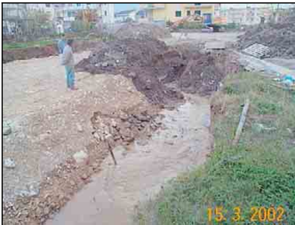
Fig. 20 – Foto mostrante la fase di riempimento del sinkhole con materiale grossolano, fornita dal Dott. Geol. G. Moriello.
