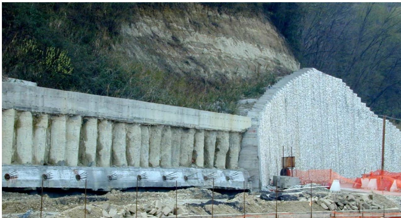
Lavori d'adeguamento alla terza corsia autostradale dell'A1 nel tratto Orte -Fiano Romano, presso Nazzano Torrita Tiberina. Paratia di pali trivellati accostati, di grande diametro, collegati in testa con una trave cordolo in calcestruzzo, ed ancorata nel terreno con tiranti lunghi circa 70 m ed oltre. Questa tipologia d'opera di sostegno, realizzata per permettere la costruzione di una nuova galleria artificiale, consente da un lato di sostenere e consolidare l'alta parete in terreni sabbioso-limosi ed argillosi e dall'altro di operare in condizioni di sicurezza, rendendo minimi gli sbancamenti e senza alterare troppo la morfologia del luogo.
