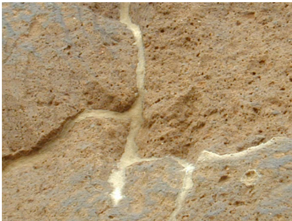
Particolare di sigillatura in una parete tufacea mediante iniezione di miscele consolidanti.
