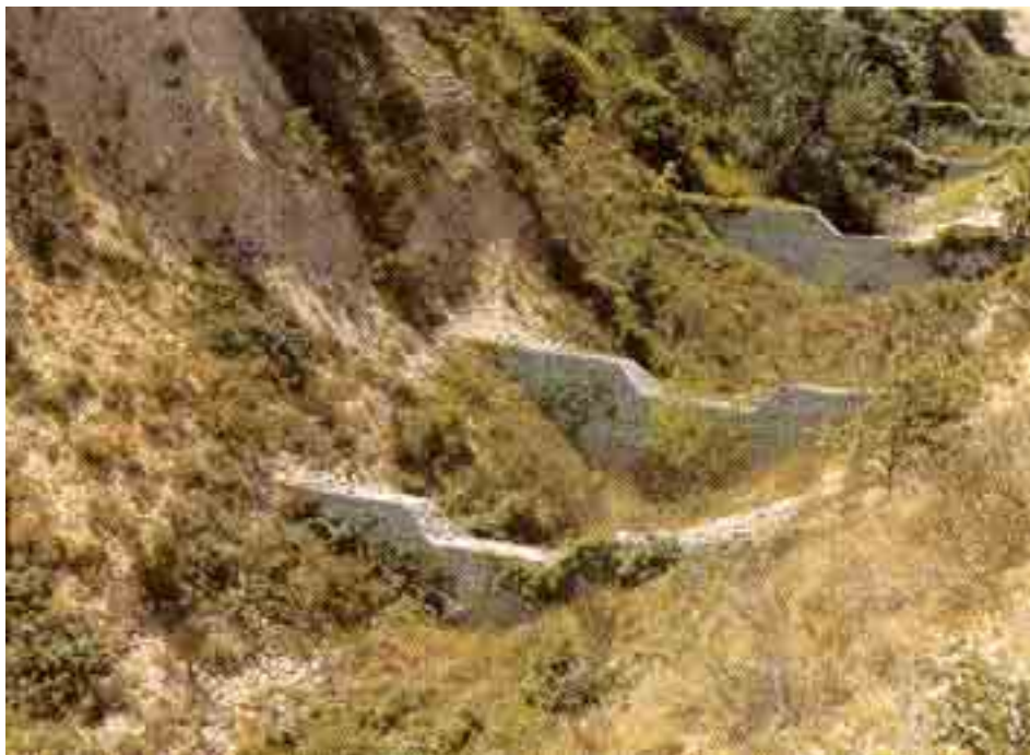
Figura 6.1.21: Una sistemazione a gradinata con briglie in gabbioni in una incisione in formazioni di tipo calanchivo. Le briglie non sono ancora state riempite a tergo dai sedimenti.
