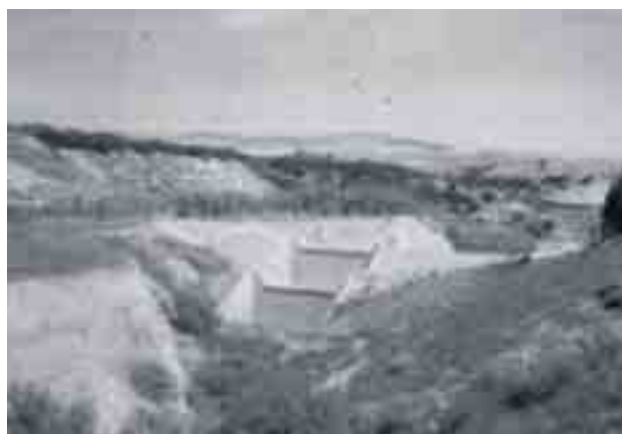
Figura 6.1.31: Esempio di briglia in terra con sfioratore in calcestruzzo. La foto in basso ripresa in un tempo successivo rispetto alla foto sopra, mostra il rialzo effettuato in seguito al riempimento della struttura inferiore. (da Puglisi & Trisorio-Liuzzi, 1992).
