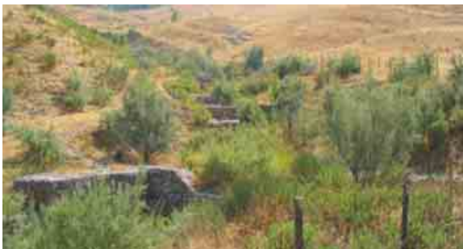
Figura 6.1.12: Sistemazione di un torrente con briglie in gabbioni in ambiente calanchivo (Petràlia PA).
