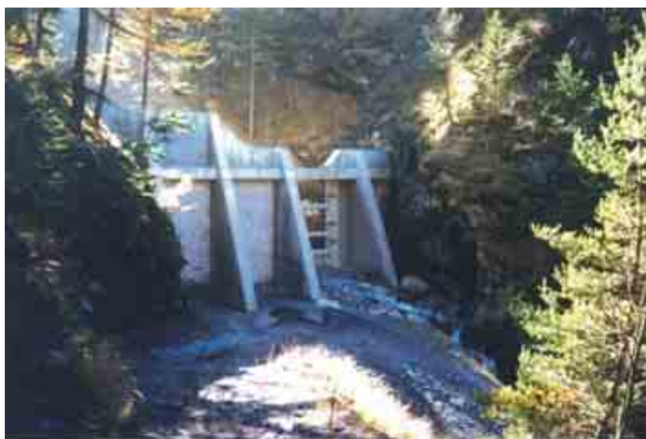
Figura 6.1.28: Esempio di briglia a contrafforti a monte con apertura sbarrata da profilati in acciaio adatta al controllo delle piazze di deposito. I profilati possono essere rimovibili per facilitare lo svuotamento. (T. Champegron, Oulx, TO).
