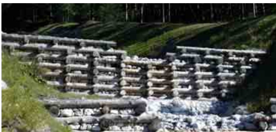
Figura 6.1.14: Briglie in legname e pietrame costruite sulla conoide incisa di un torrente (Friuli).
