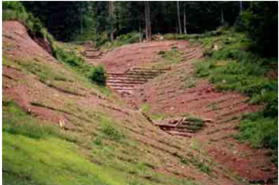
Figura 6.1.17: Sistemazione a gradinata con briglie in legname pietrame, con gaveta rivestita in tondame di piccolo diametro si notino inoltre le talee di salice inserite nelle ali delle briglie. Sulle sponde rimodellate si possono osservare opere di stabilizzazione realizzate con talee di salice (gradonate vive).
