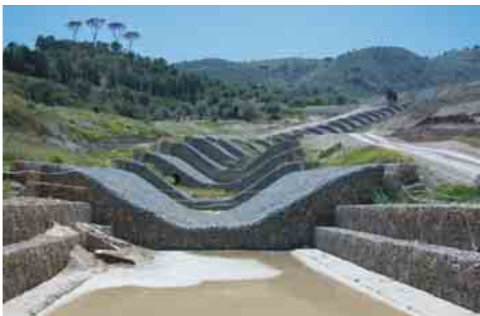
Figura 6.1.4: Sistemazione a gradinata in gabbioni e materassi. Lavori complementari sulla autostrada Messina - Palermo.
