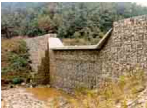
Figura 6.1.20: Nella foto: briglia in gabbioni a paramento verticale e gaveta rivestita in calcestruzzo. Il paramento ai lati della gaveta, dove non è sottoposto all'azione dell'acqua e del trasporto solido, è gradonato per migliorare la stabilità della struttura. Nel disegno si osserva l'immorsamento delle ali della stessa briglia e le fondazioni su pali per prevenire lo scalzamento
