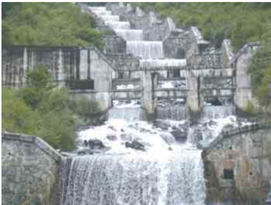
Figura 6.1.1: Sistemazione a gradinata a monte di una briglia a finestre. Le briglie a gravità in calcestruzzo hanno il paramento rivestito in pietrame (Valtellina).
