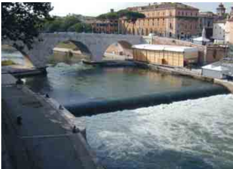
Figura 6.1.36: Le soglie vengono utilizzate anche isolatamente per controllare localmente la quota di fondo di un corso d'acqua. Questo avviene normalmente nei fiumi, presso i ponti, dove è necessario preservare le pile dallo scalzamento dovuto all'aumento di velocità dell'acqua ed all'evoluzione a più grande scala dell'alveo.
