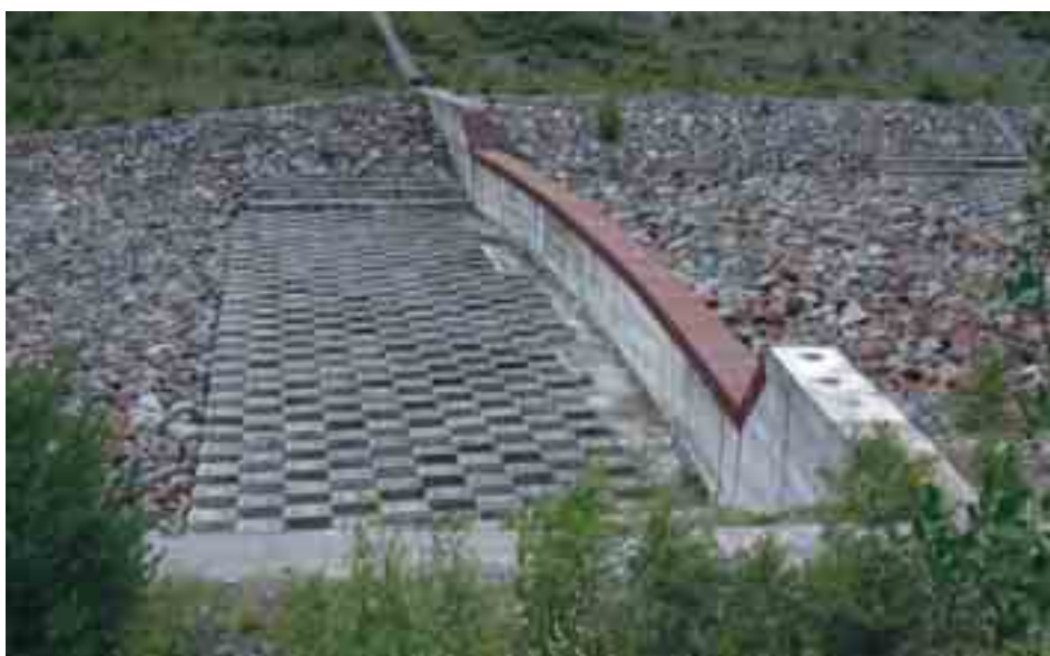
Figura 6.1.3: Val Pola (SO). Immediatamente valle del sistema briglie della foto precedente, è stata realizzata una protezione con prismi di cemento armato su pali, per impedire lo scavo da parte della corrente.
