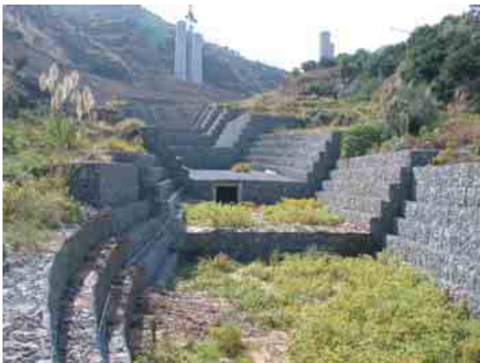
Figura 6.1.22: Sistemazione in gabbioni realizzata nell'ambito delle opere accessorie per l'autostrada Messina-Palermo.
