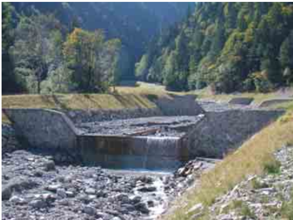
Figura 6.1.10: Briglia a gravità in calcestruzzo con paramento rivestito in pietrame.
