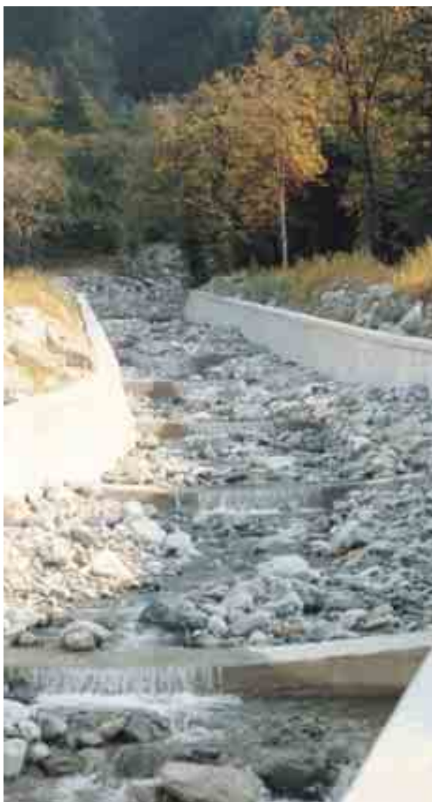
Figura 6.1.35: Sistemazione a gradinata con soglie di fondo nella conoide di un torrente. Il sistema muri di sponda più soglie, impedisce la divagazione laterale del torrente e l'approfondimento del fondo per erosione.
