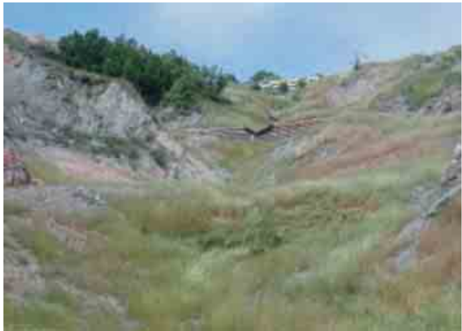
Figura 6.1.32: La foto mostra una piccola briglia in terra rinforzata completamente rinverdita costruita su un calanco; la struttura è stata realizzata col terreno stesso del calanco e rinforzata con elementi in rete metallica a doppia torsione a maglie esagonali rivestiti in materiale plastico. Sullo sfondo si vede una briglia in legname e pietrame (calanchi di Canossa)
