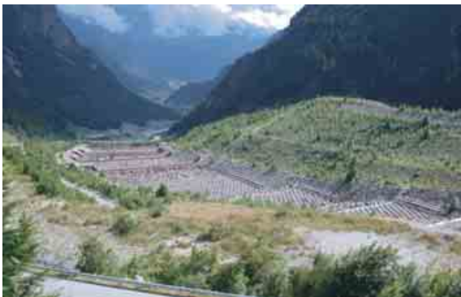
Figura 6.1.2: Sistemazione a gradinata con briglie in cemento armato, realizzata sull'accumulo detritico della frana della "Val Pola" in Valtellina (SO).
