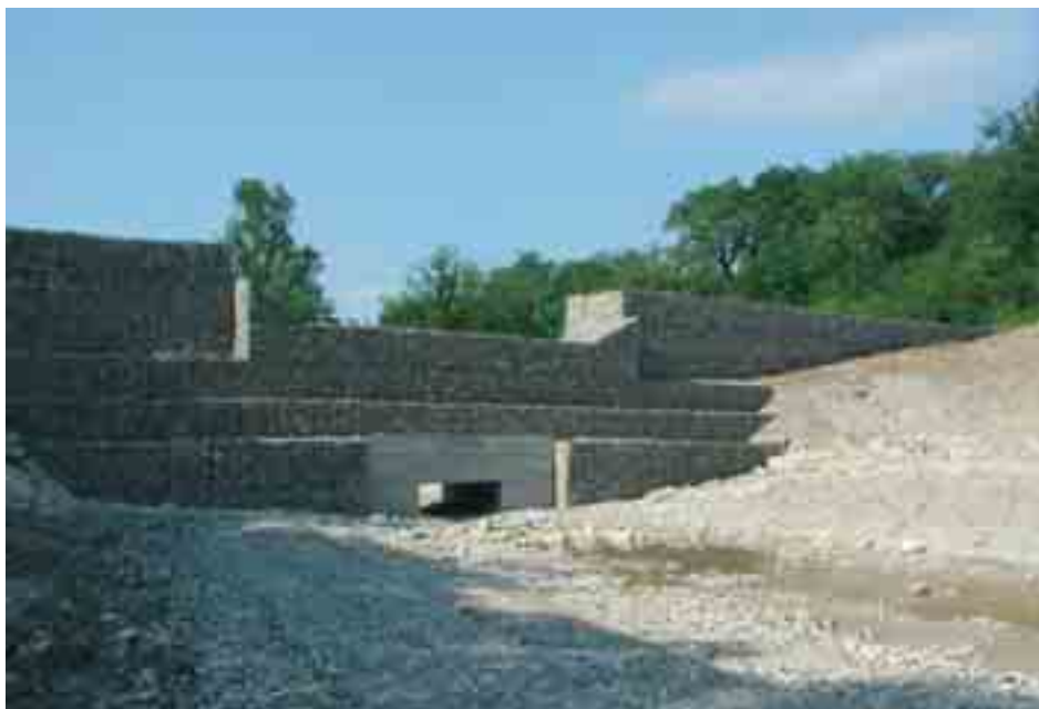
Figura 6.1.11: Briglia a gravità in gabbioni per intercettazione colate detritiche. Il normale flusso dell'acqua passa attraverso l'apertura alla base della briglia mentre il corpo del manufatto ce lo sbarramento al detrito durante la colata. La gradonatura verso valle della briglia fornisce la resistenza al ribaltamento nella fase di spinta della colata detritica.
