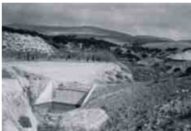
Figura 6.1.31: Esempio di briglia in terra con sfioratore in calcestruzzo. La foto in basso ripresa in un tempo successivo rispetto alla foto sopra, mostra il rialzo effettuato in seguito al riempimento della struttura inferiore. (da Puglisi & Trisorio-Liuzzi, 1992).
