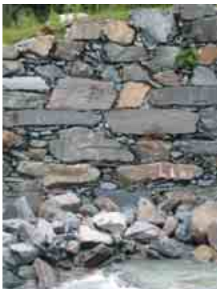
Figura 6.3.6: La costruzione di una muratura a secco, oltre all'aspetto funzionale può avere una valenza estetica.
