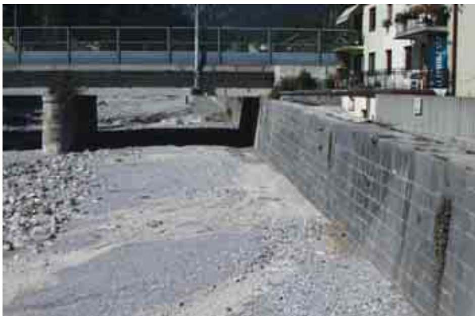
Figura 6.3.8: Muro in blocchi di roccia squadri cementati con malta idraulica.
