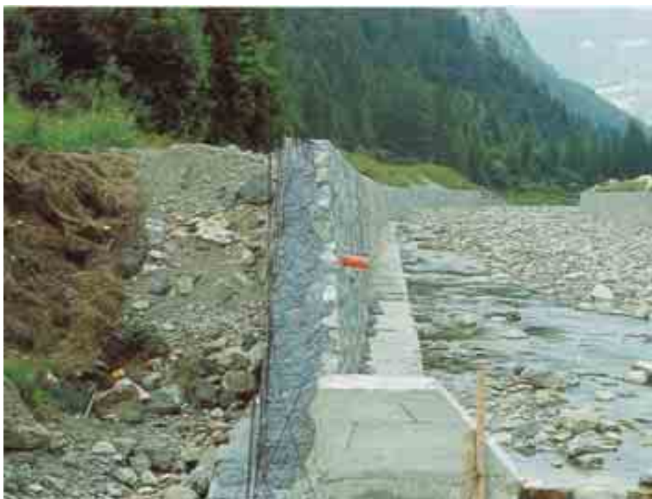
Figura 6.3.10: Opera di sostegno spondale realizzata in cemento armato con cassaforma a perdere rivestita in pietrame. Il tubo in PVC materializza la feritoia per il drenaggio.
