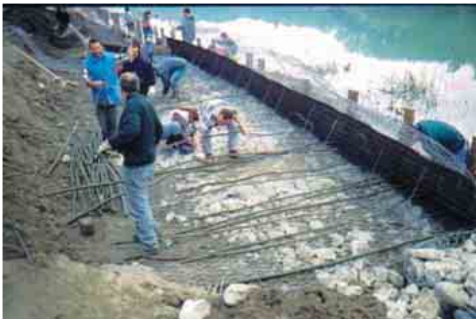
Figura 6.3.21: Costruzione di una terra rinforzata lungo un fiume. La vegetazione svolgerà una importante funzione di consolidamento e protezione superficiale. Per una buona riuscita degli interventi è necessario mettere a dimora astoni di salice durante la costruzione, spingendoli il più possibile all'interno della struttura, possibilmente fino a raggiungere il terreno a tergo dell'opera. Fiume Reno presso Casalecchio (BO).
