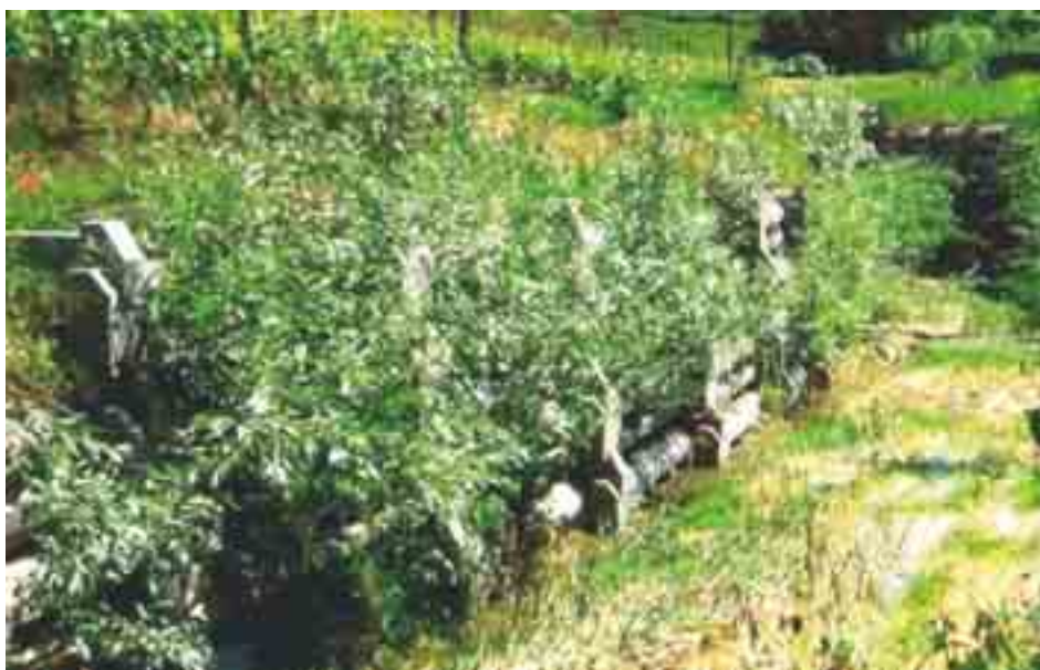
Figura 6.3.16: Un muro cellulare in calcestruzzo abbinato a talee di salice, ripreso dopo tre anni dalla costruzione. L'opera è stata costruita dopo l'evento alluvionale del 1994 a protezione delle sponde del Rio S. Grato nel Comune di S. Stefano Belbo (CN). Il miglioramento dell'inserimento ambientale sia sotto il profilo estetico che naturalistico è evidente.
