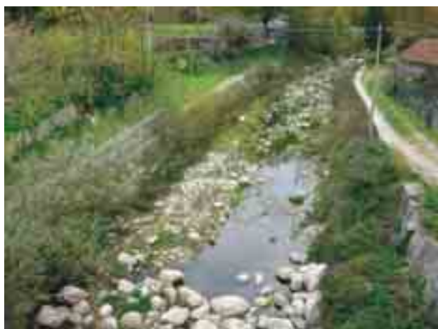
Figura 6.3.30: Muro in gabbioni abbinato a talee durante le successive fasi di rinverdimento. Le foto della gabbionata sono state riprese a distanza di un anno per ciascuna foto, la vegetazione è all'interno della gabbionata e ricopre tutta la struttura.
