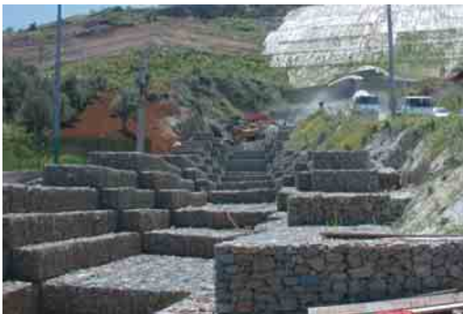
Figura 6.3.25: Gabbionate per la stabilizzazione delle sponde di un corso d'acqua in un tratto che corre in fregio ad una strada. I muri sono praticamente verticali, disponendo di più spazio è opportuno gradonare la struttura per migliorarne la stabilità e diminuire l'impatto visivo.
