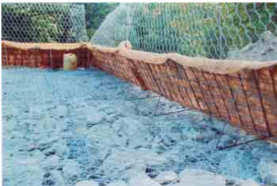
Figura 6.3.20: Fase iniziale di costruzione di una struttura in terra rinforzata. Si osserva come il primo strato della struttura venga posato sulla fondazione in gabbioni con funzione antierosiva.
