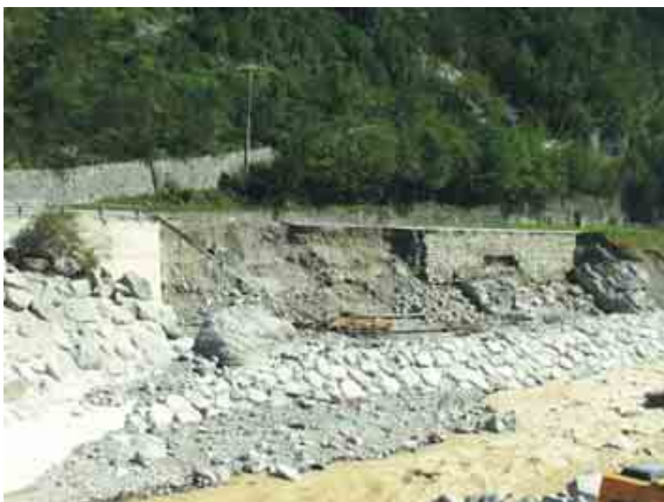
Figura 6.3.3: Erosione che ha intaccato la fondazione di un muro di sponda in pietrame e malta causandone la rottura.
