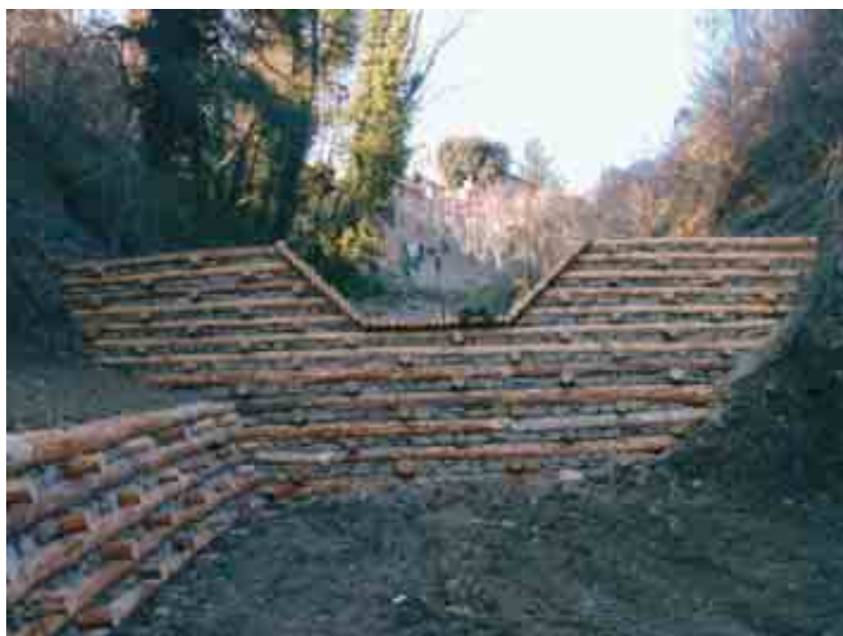
Figura 6.3.35: L'immagine ritrae una briglia e una palificata doppia in legname e pietrame (Castiglion Fibocchi AR).
