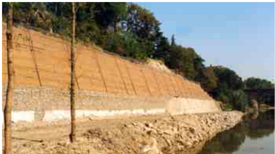
Figura 6.3.19: Intervento di ricostituzione di un versante prospiciente il fiume Reno. Al piede della scarpata è stata realizzata una terra rinforzata con paramento riempito in pietrame a gradoni con il duplice effetto di costituire una base stabile al terrapieno in terra rinforzata verde e di fornire la difesa all'erosione nel caso di piene.
