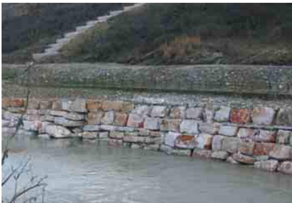
Figura 6.3.5: Sistemazione spondale con muratura di massi ciclopici. I blocchi calcarei di grandi dimensioni sono squadriati per facilitarne la sistemazione e vengono movimentati con gli escavatori idraulici. Quando il materiale che costituisce la sponda ha una granulometria fine è opportuno interporre tra questo ed il muro un geotessile con funzione di filtro. Fiume Biferno (Molise).
