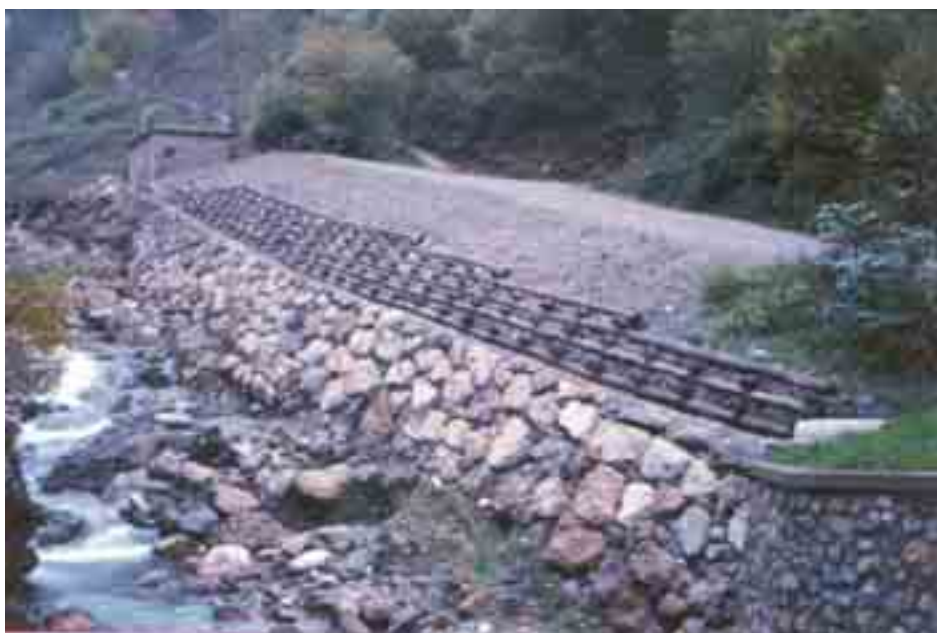
Figura 6.3.7: sistemazione spondale con muratura di massi di grosse dimensioni sovrastati da muro di sostegno eseguito con palificata a parete doppia in legname. E' evidente l'ottimo livello di integrazione con l'ambiente circostante e in abbinamento con l'opera in legname. L'utilizzo di due diverse tecniche in questo caso ha consentito di ottimizzare l'inserimento mantenendo la funzionalità tecnica, grazie all'uso di una struttura più resistente all'azione della corrente nella parte più esposta.
