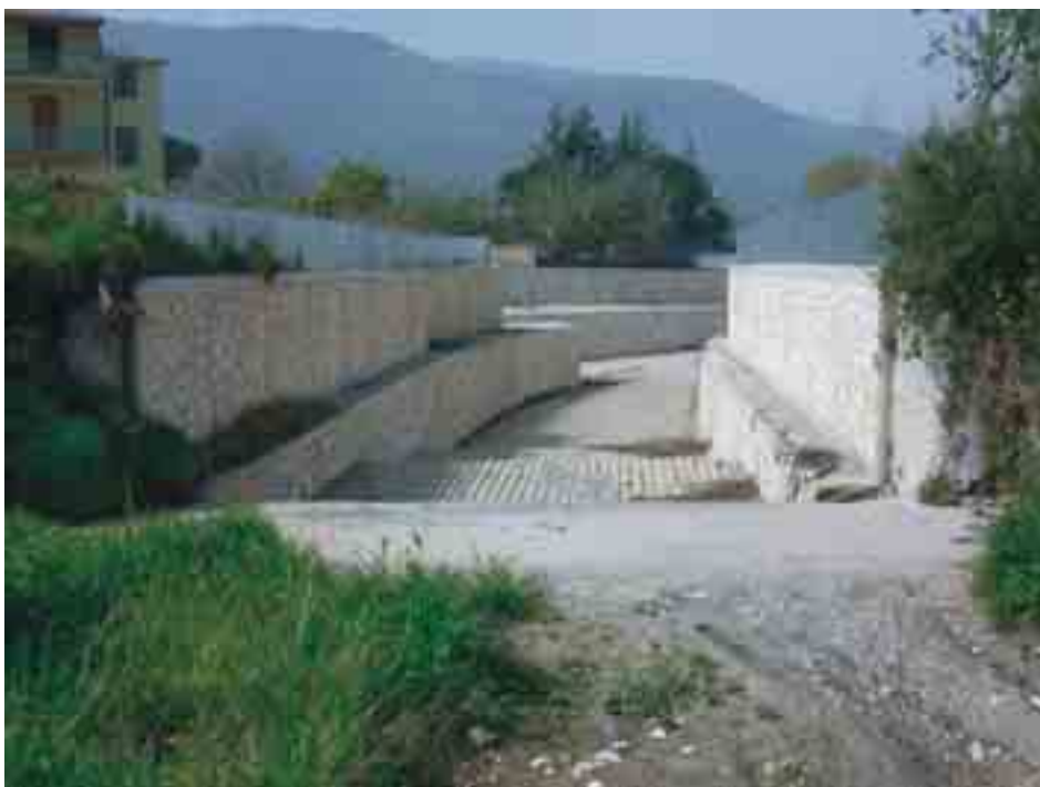
Figura 6.3.12: Muro in cemento armato prefabbricato, con rivestimento in pietra a vista. Si distinguono i singoli elementi prefabbricati accostati che costituiscono il muro (Quindici AV).
