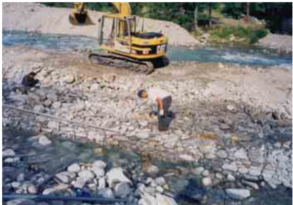
Figura 6.3.28: Costruzione di un muro in gabbioni in un torrente in Val d'Aosta (Cogne). I gabbioni vengono riempiti con materiale lapideo reperito direttamente in alveo dove è presente in eccesso. La soluzione scelta per la fondazione, a causa del forte trasporto solido, è quella dell'approfondimento del piano di fondazione invece dell'impiego di una platea flessibile.
