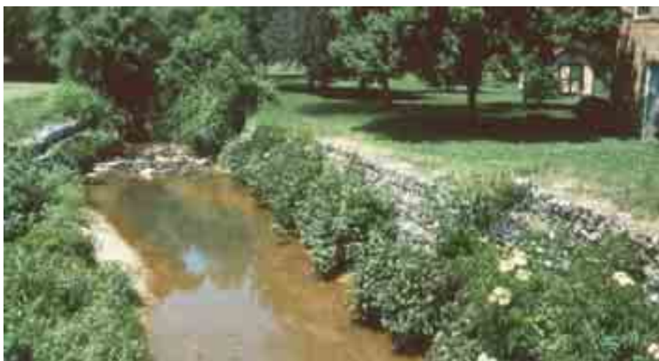
Figura 6.3.26: Gabbionata rinverdita. I singoli elementi scatolari hanno lunghezza diversa in modo da gradonare il paramento del muro. Durante la costruzione, nella porzione al di sopra del livello medio dell'acqua, sono state messe a dimora delle talee di salice che consolidano la struttura e consentono una buona rinaturalizzazione delle sponde in tempi relativamente brevi.
