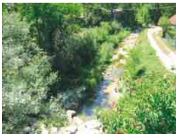
Figura 6.3.30: Muro in gabbioni abbinato a talee durante le successive fasi di rinverdimento. Le foto della gabbionata sono state riprese a distanza di un anno per ciascuna foto, la vegetazione è all'interno della gabbionata e ricopre tutta la struttura.
