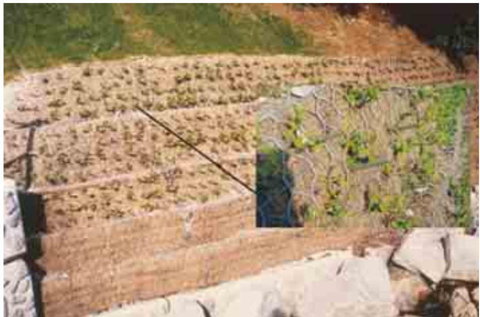
Figura 6.3.18: La possibilità di rinverdire le terre rinforzate usando specie erbacee ed arbustive, offre indubbi vantaggi sotto il profilo ambientale. Nella foto a fianco si può osservare la messa a dimora di talee in una terra rinforzata con elementi in rete metallica a doppia torsione plasticata, con paramento protetto con biostuoia. In fondazione la protezione antierosiva è assicurata da una piccola scogliera.
