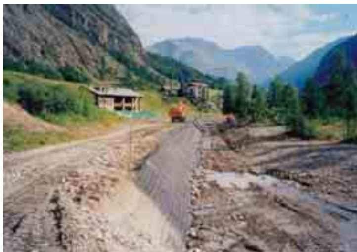
Figura 6.3.23: Terra rinforzata realizzata lungo una sponda di un piccolo torrente in ambiente alpino. Il paramento è rivestito con geostuoia tridimensionale in polipropilene e può venire rinverdito con una idrosemina a spessore
