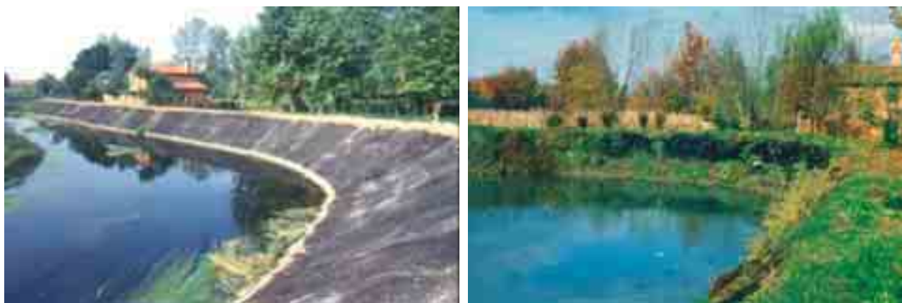
Figura 6.4.38: Protezione di un argine fluviale mediante rivestimento con geostuoia tridimensionale piantumata a caldo. Nella foto successiva si può osservare la prima fase di rinverdimento. Dopo 12 anni dall'intervento la sponda è risultata completamente inerbita e non vi è più traccia della bitumatura. F. Zero (TV)
