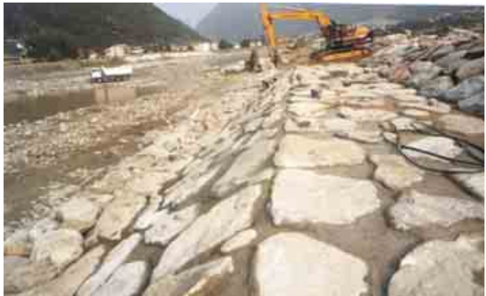
Figura 6.4.14: Scogliera in massi cementati per aumentarne la stabilità. La cementazione rende l'opera più rigida e meno permeabile.
