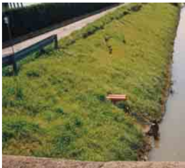
Figura 6.4.43: Aspersione della miscela di matrice a fibre legate sulla sponda di un canale. La copertura deve essere completa e ed effettuata con quantità minime di prodotto per mq, al di sotto delle quali non bisogna scendere per ottenere risultati ottimali. L'idroseminatrice usata per l'applicazione, deve possedere una pompa volumetrica per non rovinare i semi frantumandoli e deve essere dotata di lance idonee allo spargimento omogeneo della miscela. A distanza di qualche mese dall'applicazione, la copertura erbacea si è sviluppata molto bene su tutta la sponda mostrata nella foto precedente.
