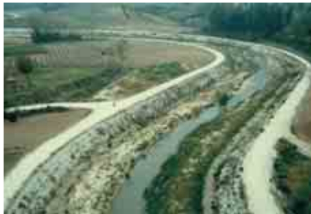
Figura 6.4.22: I materassi vengono facilmente colonizzati dalla vegetazione. La frazione limosa del trasporto solido intasa i vuoti tra i ciottoli e la vegetazione pioniera si instaura nel giro di pochi anni. Nella foto opera spondale in materassi in ambiente appenninico. A distanza di un anno è iniziata la colonizzazione spontanea.
