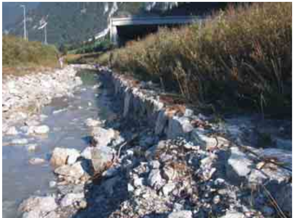
Figura 6.4.15: Una soluzione che consente di migliorare significativamente la resistenza al trascinamento della scogliera è quella di vincolare i blocchi con funi d'acciaio. Il sistema è allunga significativamente i tempi di realizzazione ed leva i costi dell'opera.
