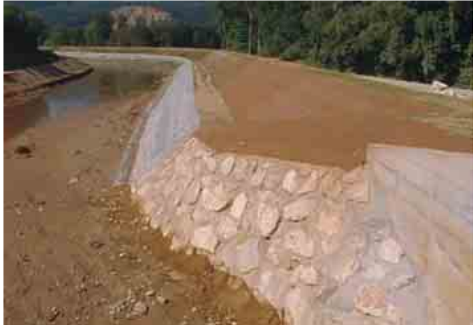
Figura 6.4.21: Protezione di una materassata nella tratto iniziale a valle di un ponte. Per evitare l'aggiramento si è impiegata una scogliera in blocchi cementati.
