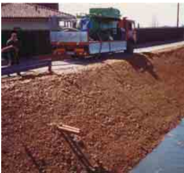
Figura 6.4.43: Aspersione della miscela di matrice a fibre legate sulla sponda di un canale. La copertura deve essere completa e ed effettuata con quantità minime di prodotto per mq, al di sotto delle quali non bisogna scendere per ottenere risultati ottimali. L'idroseminatrice usata per l'applicazione, deve possedere una pompa volumetrica per non rovinare i semi frantumandoli e deve essere dotata di lance idonee allo spargimento omogeneo della miscela. A distanza di qualche mese dall'applicazione, la copertura erbacea si è sviluppata molto bene su tutta la sponda mostrata nella foto precedente.
