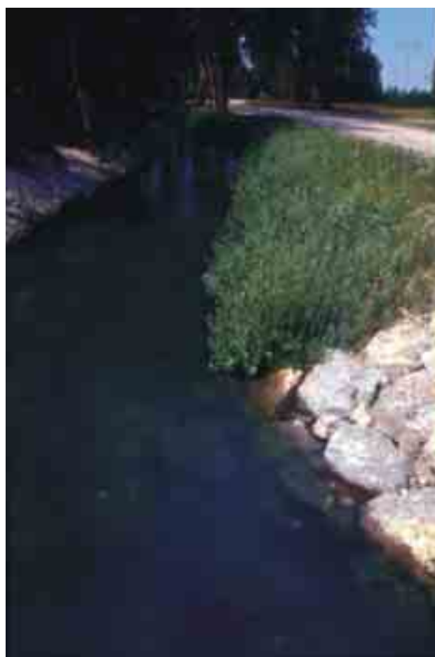
Figura 6.4.53: La costruzione della copertura diffusa e terminata, la sponda è coperta in maniera continua dalla ramaglia, che è solidamente fissata alla sponda per mezzo dei correnti ancorati ai paletti verticali. Nel giro di un anno si imposterà una vegetazione fitta ed elastica, dotata di una capacità protettiva molto elevata.
