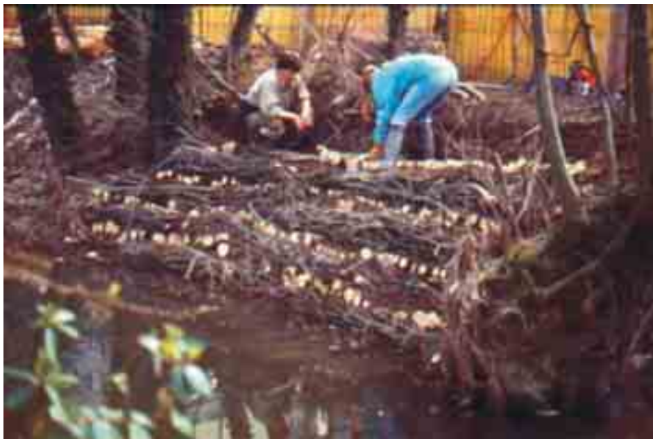
Figura 6.4.50: Costruzione di una ribalta viva: si stanno posando gli elementi trasversali (in questo caso delle talee al posto della ramaglia). Al di sopra verrà posata una ulteriore fascina e poi si completerà con un riempimento con terreno nella parte sommitale dell'opera. Sponda sin. Immissario lago di Lugano.
