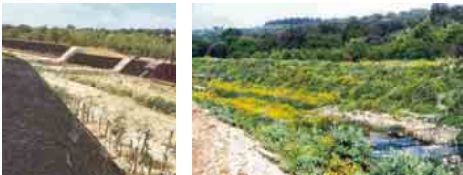
Figura 6.4.36: Sponde di una fiumara rivestite con geostuoia tridimensionale rinforzata e rinverdite.
