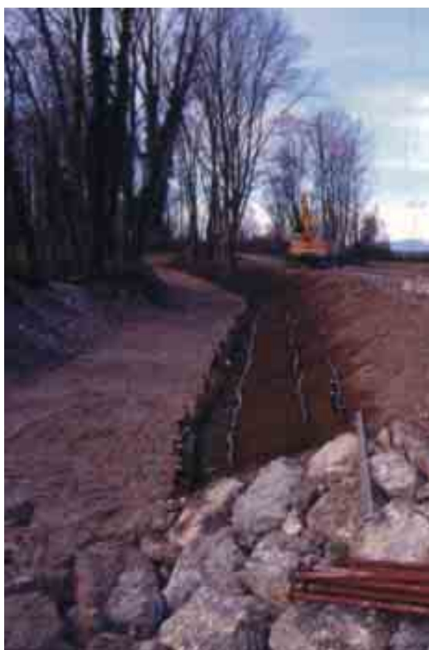
Figura 6.4.53: La costruzione della copertura diffusa e terminata, la sponda è coperta in maniera continua dalla ramaglia, che è solidamente fissata alla sponda per mezzo dei correnti ancorati ai paletti verticali. Nel giro di un anno si imposterà una vegetazione fitta ed elastica, dotata di una capacità protettiva molto elevata.
