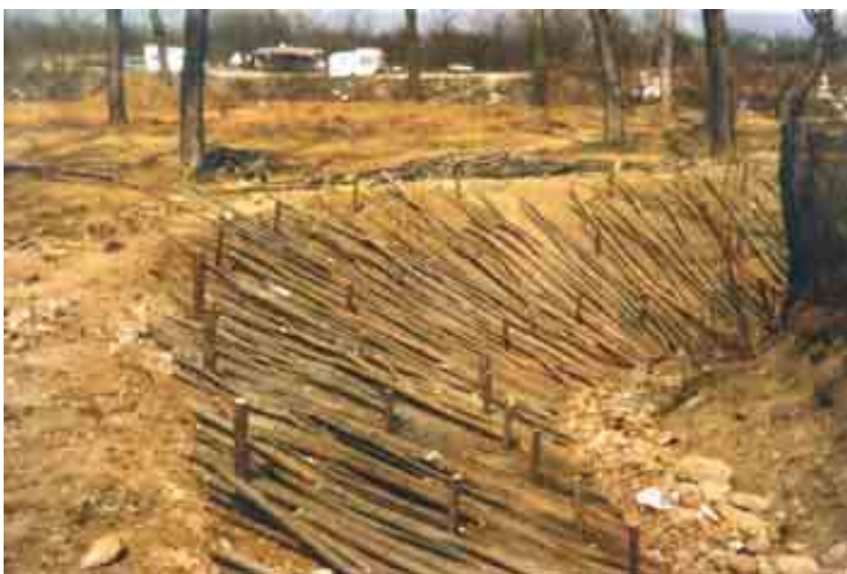
Figura 6.4.52: Realizzazione di una copertura diffusa con astoni di salice. Si osservino i paletti verticali usati per fissare i correnti che verranno posati successivamente sugli astoni.
