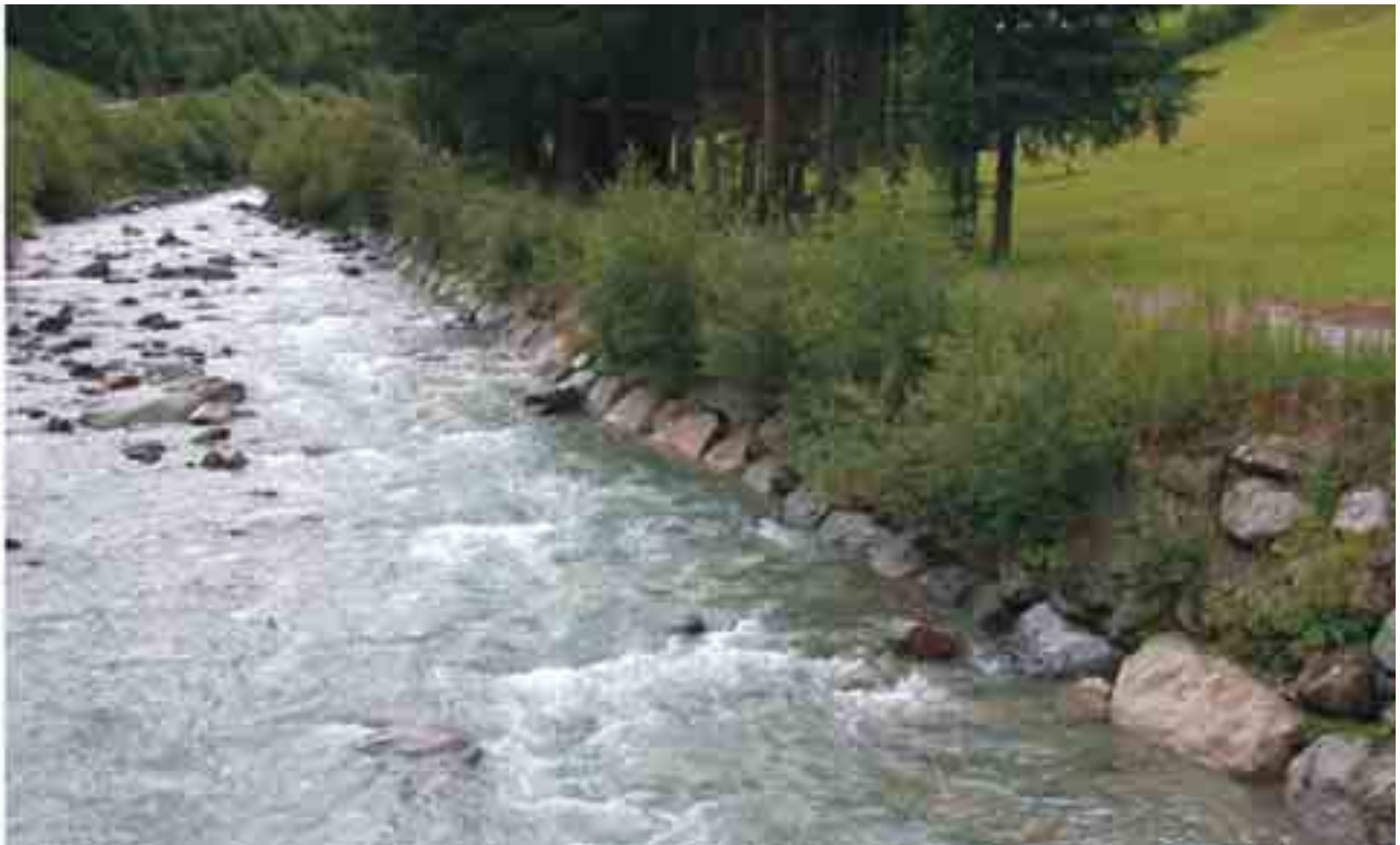
Figura 6.4.17: Scogliera in blocchi calcarei piantata con talee di salice. I salici messi a dimora durante la costruzione hanno attecchito senza problemi e stanno coprendo la scogliera.
