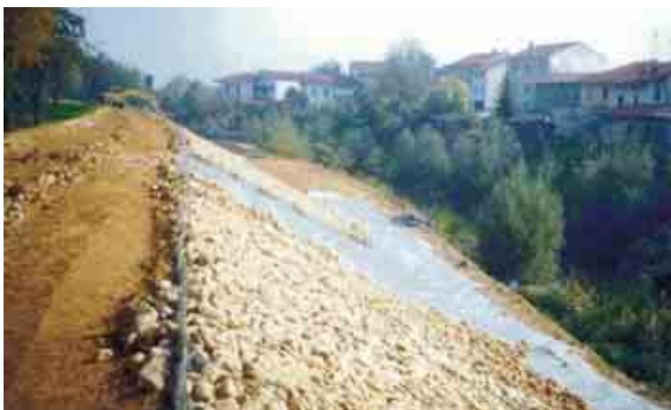
Figura 6.4.26: La foto accanto e quella sopra mostrano la parte alta di una sponda rivestita in materassi intasati con terreno e rinverditi. Si osservi che nella parte bassa della sponda, dove si prevedono tensioni di trascinamento più elevate, è stata realizzata una scogliera.
