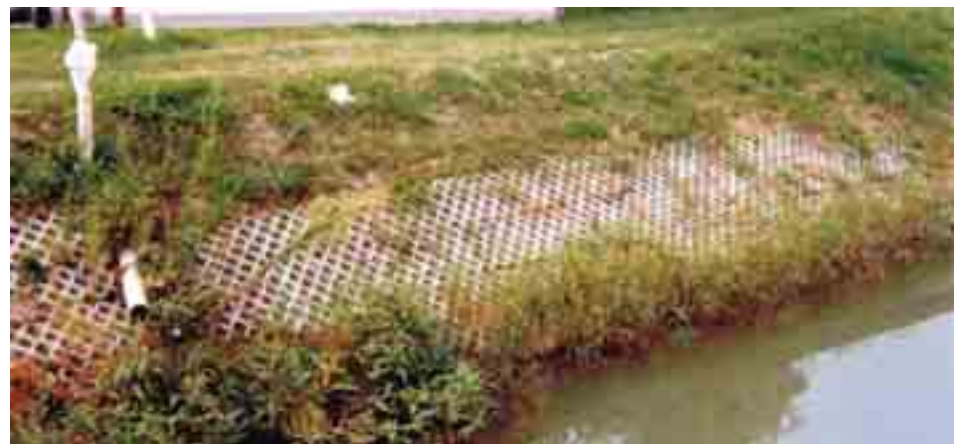
Figura 6.4.8: Esempio di rivestimento in lastre traforate in cemento a protezione di una sponda di un canale.
