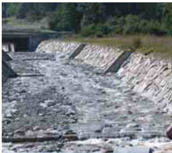
Figura 6.4.4: Rivestimento di fondo di un corso d'acqua, realizzato con pietrame calcareo, squadrato sistemato in maniera regolare.
