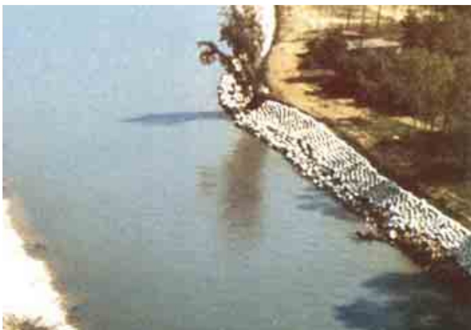
Figura 6.4.10: In assenza di blocchi naturali si possono utilizzare prismi di calcestruzzo come nell'esempio lungo il fiume Po mostrato nella foto a fianco
