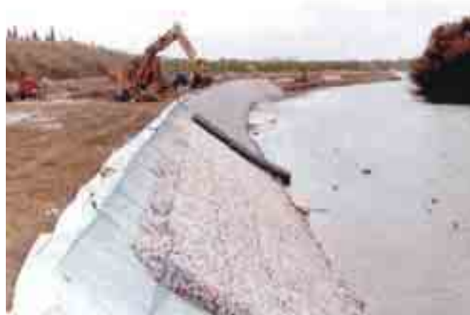
Figura 6.4.5: Posa di materassi in rete metallica a doppia torsione riempiti di pietrame. Ad ulteriore protezione del terreno della sponda è stato posto un filtro in geotessile non tessuto. Si osservi la chiusura dei materassi che viene effettuata con un unico telo di rete metallica a doppia torsione.
