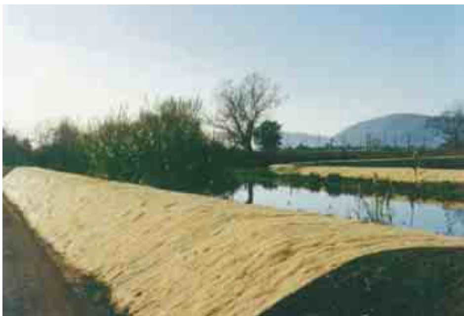
Figura 6.4.30: Rivestimento con biostuoia in fibre di legno, di rilevati arginali in terra. La biostuoia impedirà l'erosione superficiale dando modo alla vegetazione erbacea di crescere e proteggere il terreno permanentemente nei confronti delle acque di pioggia e dell'azione della corrente.
