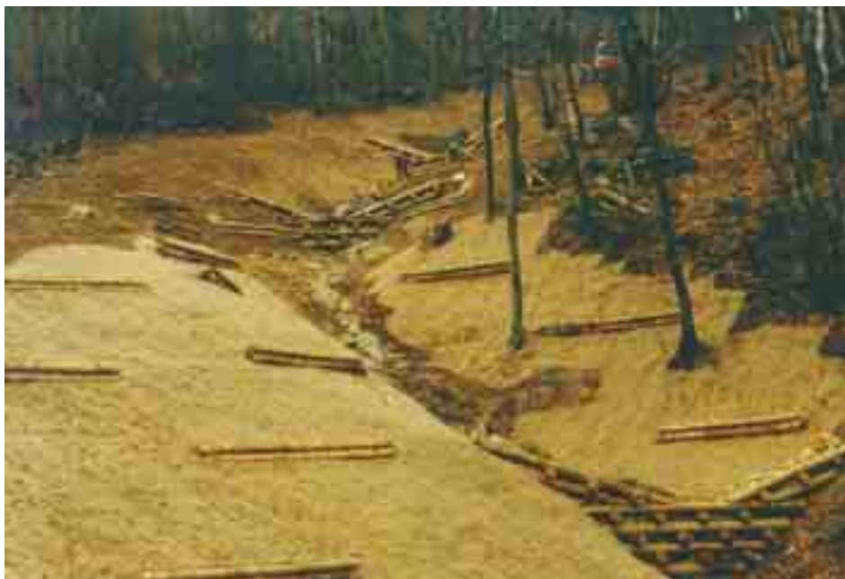
Figura 6.4.32: Rivestimento di sponde di un torrente con geodete in juta. Dopo il rimodellamento delle sponde con mezzi meccanici, è importante provvedere ad una protezione temporanea in attesa che cresca la vegetazione. Nella foto sotto si può apprezzare il risultato a distanza di poco più di un anno. Oltre alla copertura erbacea si è provveduto a mettere a dimora delle specie arbustive realizzando delle palizzate con talee (Forno Canavese, Piemonte)
