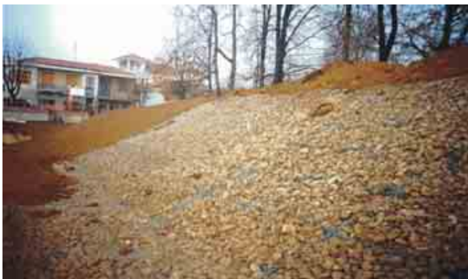
Figura 6.4.25: L'intasamento dei materassi con il terreno viene effettuato con l'escavatore idraulico e parte dalla sommità procedendo verso il basso. Questa operazione va effettuata prima di chiudere il coperchio del materasso in rete metallica.
