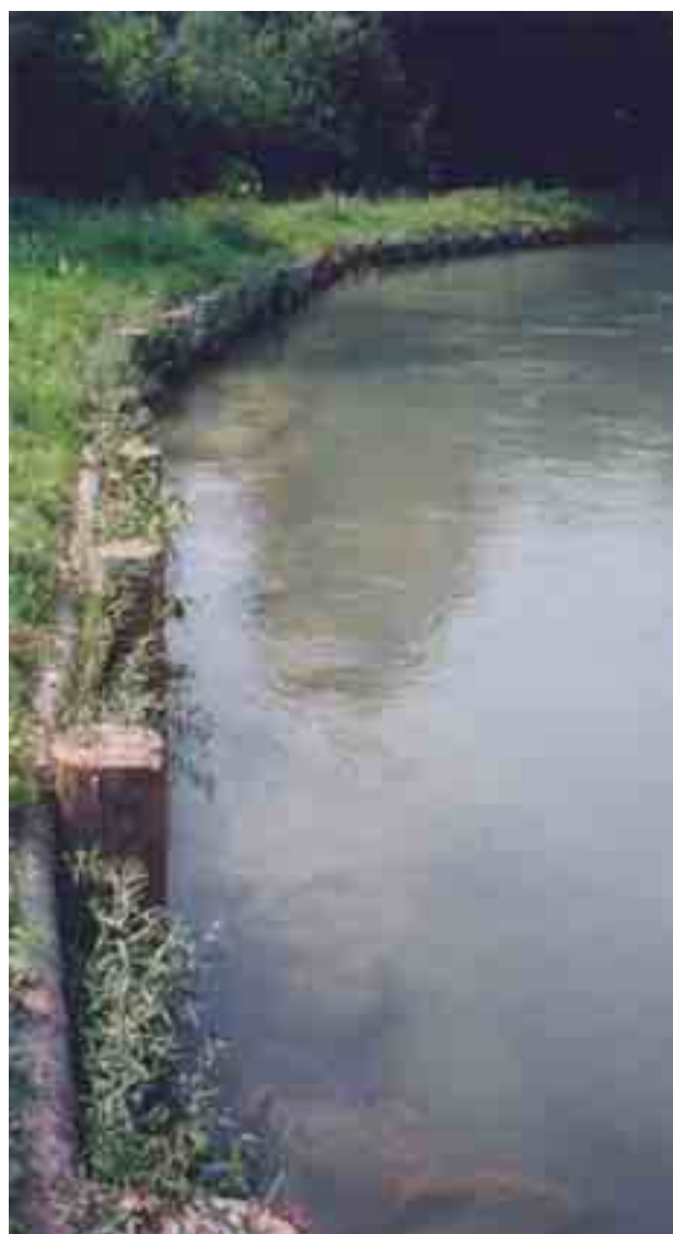
Figura 6.5.6: I salici della palificata hanno attecchito, nel giro di pochi mesi la sponda sarà rivegetata e si creeranno condizioni favorevoli per l'insediamento della fauna sia acquatica che terrestre.
