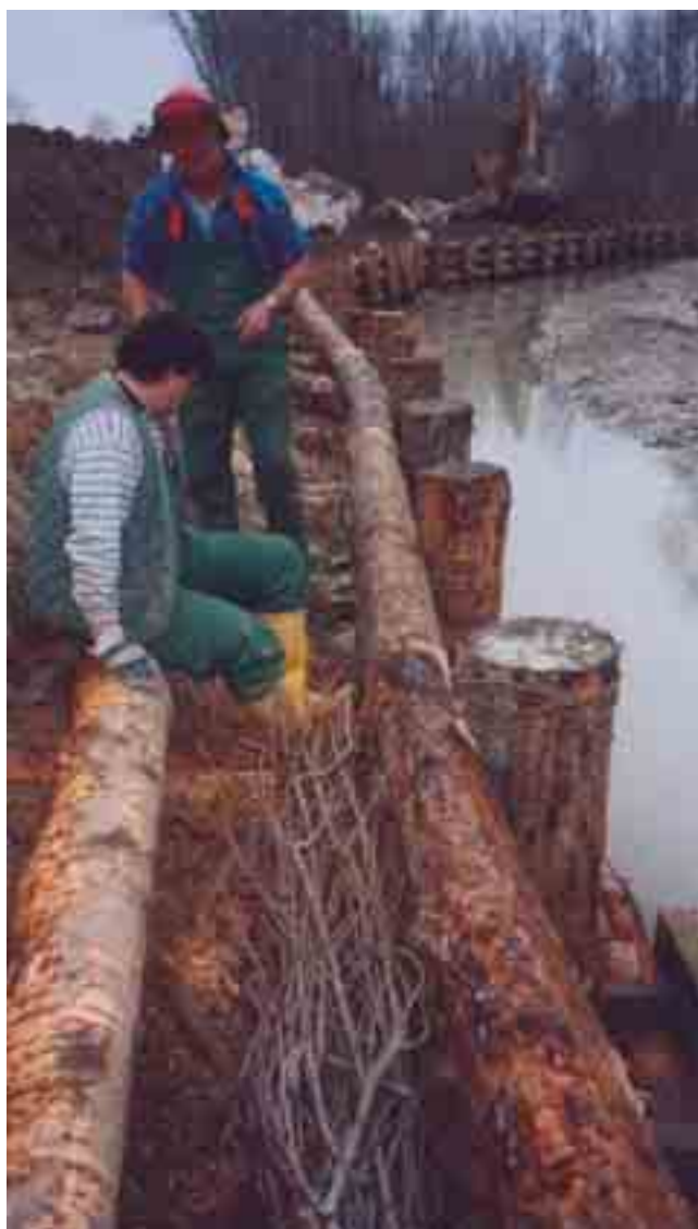
Figura 6.5.5: Le fascine poste dietro la palificata, debbono impedire l'erosione da parte dell'acqua tra un palo e l'altro, ma debbono essere anche dotate di capacità vegetativa per attecchire e consolidare permanentemente la struttura. Torrente Corno c/o, Varno (UD)
