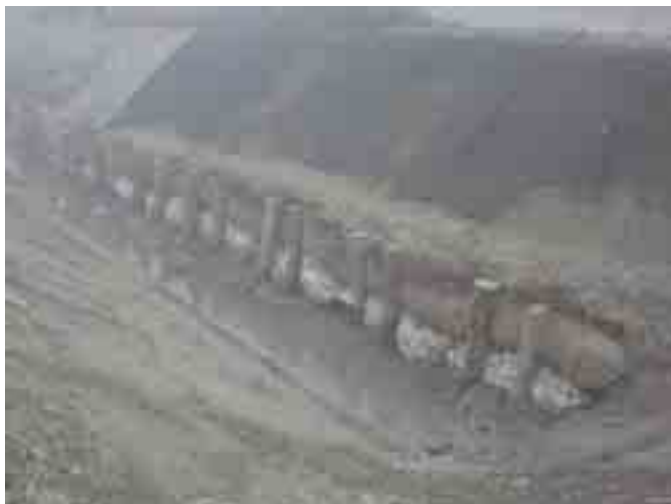
Figura 6.5.2: Esempio di presidio al piede realizzato mediante la sovrapposizione di cilindri in fibre di cocco a gabbioni cilindrici in rete metallica a doppia torsione riempiti di pietrame. I due elementi lineari addossati alla sponda sono sorretti da pali di legno di castagno infissi profondamente nell'alveo. Al di sopra dei cilindri di cocco sono state poste delle talee di salice e la sponda è stata rivestita con rete metallica a doppia torsione accoppiata con una geostuoia tridimensionale che verrà successivamente rinverditata con una idrosemina aspersore.
