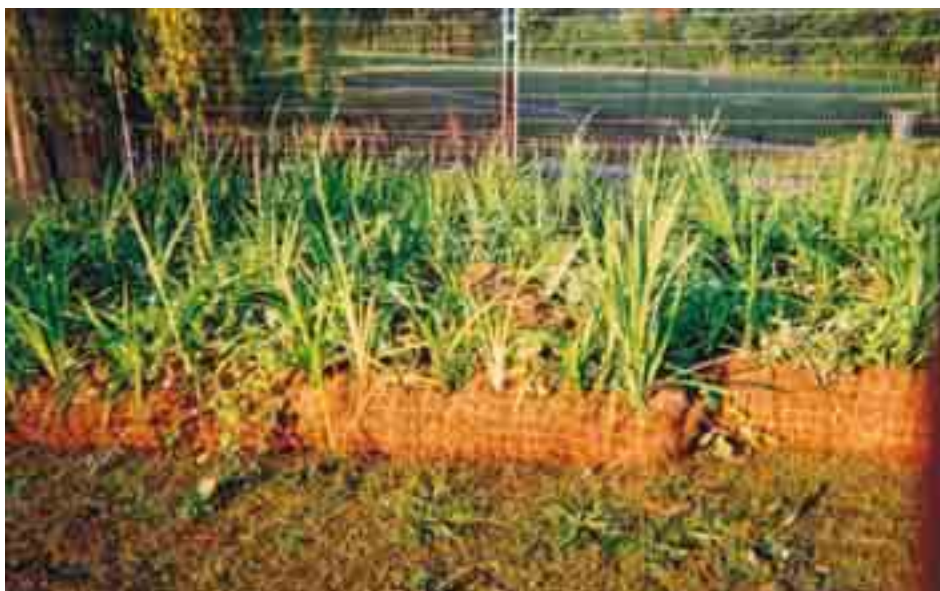
Figura 6.5.11: I rulli cilindrici possono essere predisposti piantandovi delle piante igrofile, consentendo di impiantare rapidamente della vegetazione, senza pericolo che possa venire scalzata dall'erosione della corrente.
