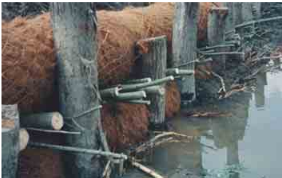
Figura 6.5.12: Il consolidamento della sponda si otterrà posando delle fascine di salici o di tamerici a tergo dei rulli ed eventualmente, al di sopra del livello dell'acqua, delle talee poste tra un rullo e l'altro.
