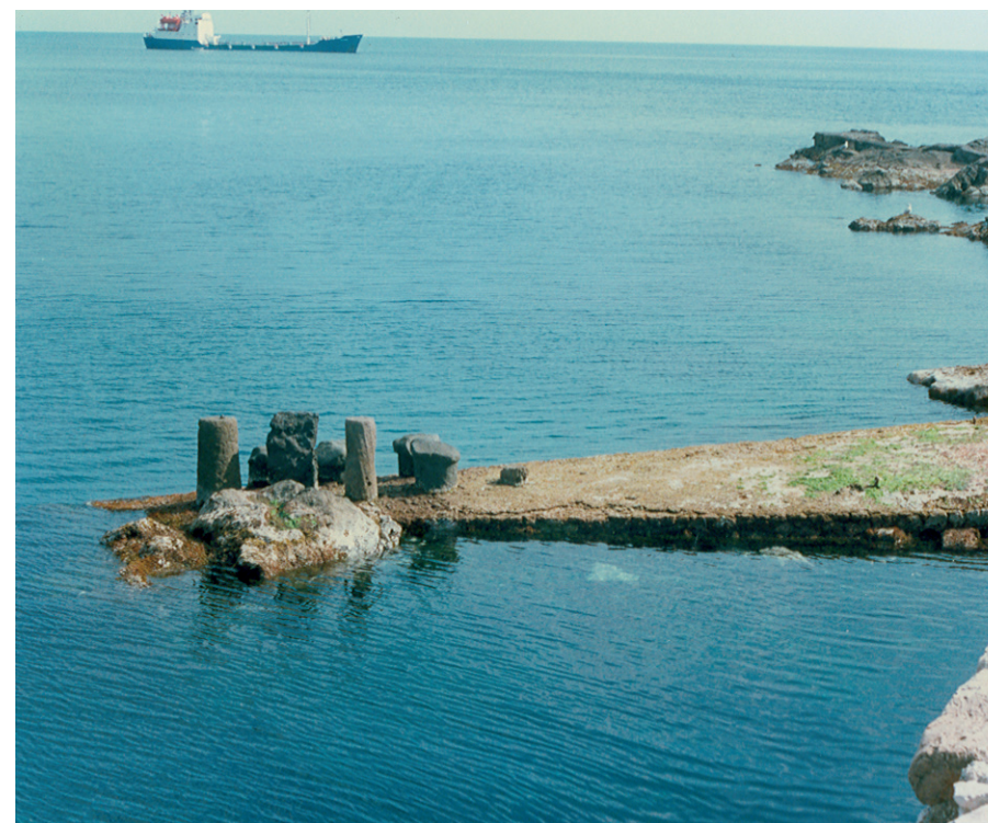
Fig. 38 - Isola di Lipari: banchina di ormeggio costruita all'inizio del XVII secolo (NEGRO & VENTIMIGLIA, in ARICÒ, 1998) e attualmente soggetta a periodica sommersione, come indicato dalla presenza di alghe verdi intertidali sulla banchina, e da colonizzazione di balanidi alla base delle bitte. (Foto: C. Romagnoli).
