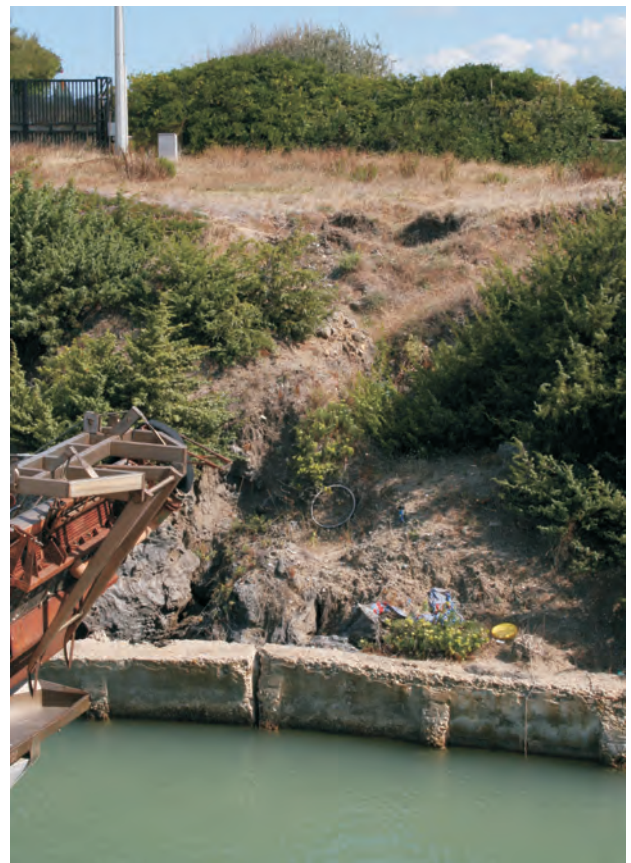
Fig. 8 – Gruppo di sprofondamenti nei pressi della foce del canale artificiale, sulla sponda orientale. - Group of sinkholes near the outlet, at the eastern side of the artificial channel.
