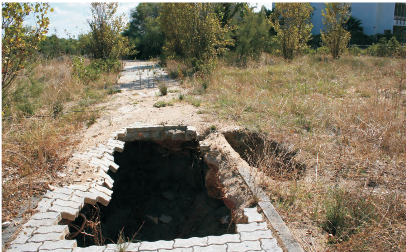
Fig. 5 - Sinkhole lungo il viale laterale, in sinistra del canale artificiale, nell'ambito del settore in cui lo sviluppo degli sprofondamenti ha maggiormente minacciato le abitazioni.
