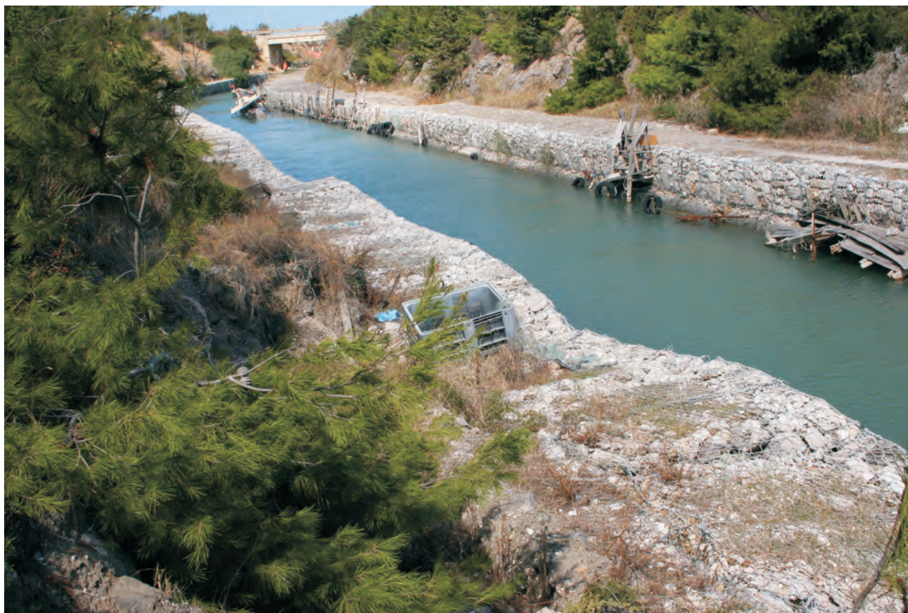
Fig. 7 – Vista di un lungo tratto del canale artificiale: sono ben evidenti le deformazioni delle gabbionate, connesse a recenti fenomeni di sinkholes .
