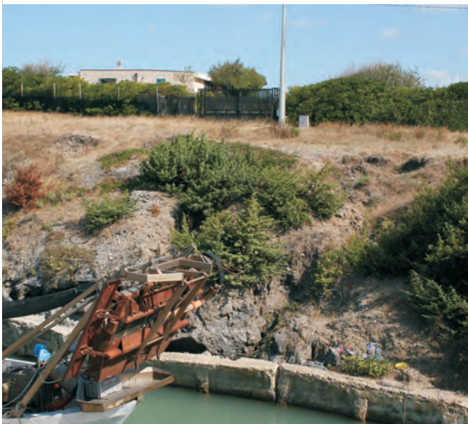
Fig. 9 – Sponda orientale del canale artificiale, nei pressi della foce: a) dissesti nei gessi, con rottura dell'argine in calcestruzzo in più punti; b) alcuni dei dissesti sono direttamente collegati ai sinkholes avvenuti sul sovrastante pianoro, al pari di quanto osservato sulla sponda opposta (vedi fig. 6). - Eastern side of the artificial channel, near the outlet: a) slope movements in the evaporites, breaking the concrete bank walls; b) some of the slope movements are directly linked to the sinkholes occurring on the plain above, as already observed on the opposite bank (see fig. 6).
