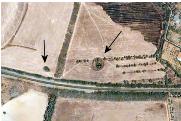
Fig 8 - Ortofoto di alcuni sinkholes nei pressi della linea ferroviaria. - Ortophoto of some sinkholes near the railway line.
