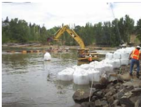
Figura 12.10- Messa in opera di barriere attive (da Trattamenti in-situ: capping in situ status (cap7) di Rodolfo M. A. Napoli e al. – www.campusunipertnopo.it ).
