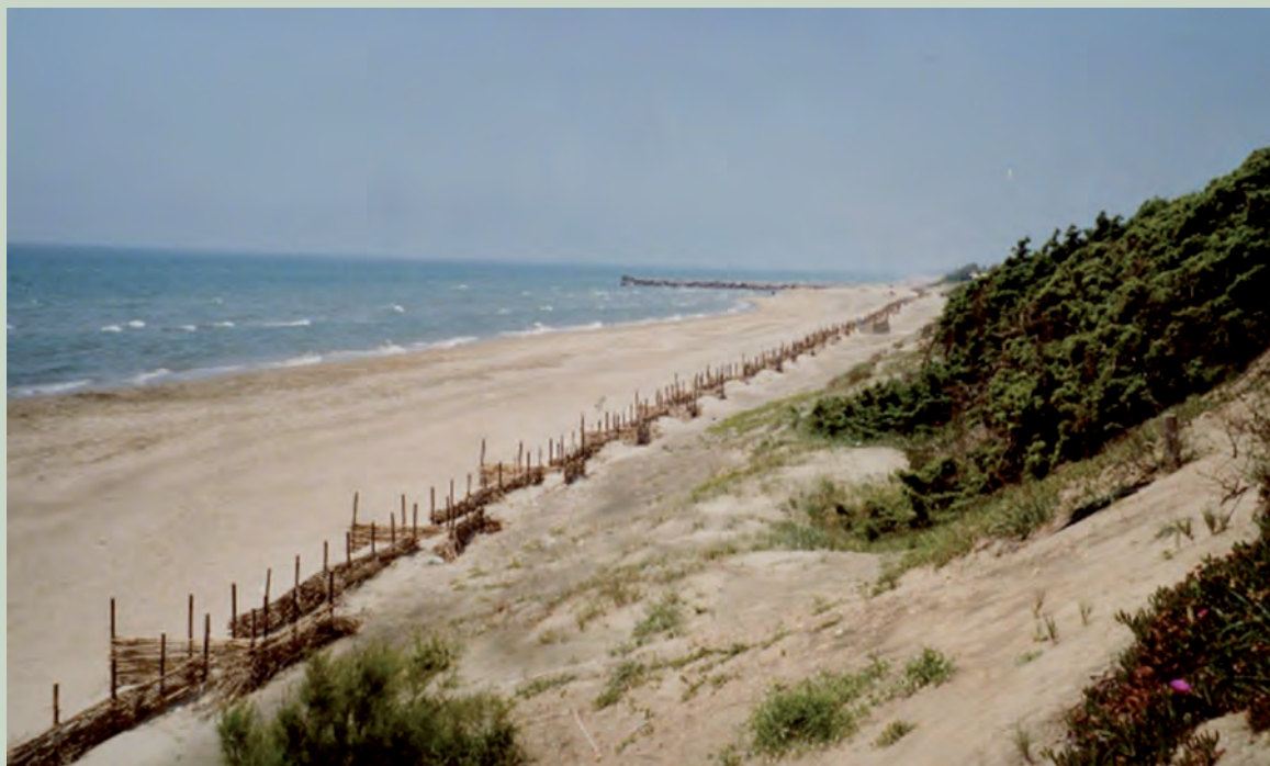
Fig. 15: Costruzione di barriere basali in viminate, chiusura dei varchi mediante palizzate e realizzazione di schermi frangivento nel Parco Nazionale del Circeo (Foto Salvatore Puglisi, 2000)
