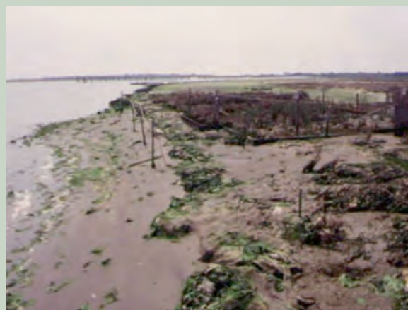
Fig. 21 e 22: Ricostruzione di isolotti con dragaggi a matrice sabbiosa con prove di messa a dimora di specie alofile, nella laguna di Caleri – Po di Levante (RO) (Foto Giuliano Sauli)
