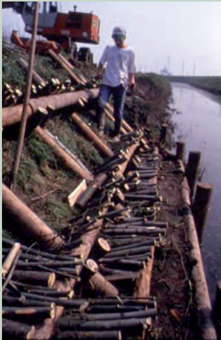
Figg. 14 e 15: Palificata e grata viva con salici in un canale del delta Po, in provincia di Rovigo, in fase di realizzazione (a sx) e dopo alcuni anni (a dx)
