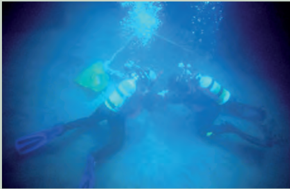
Fig. 4: Posa in opera del materasso sul fondale (Foto da F. Boccalaro, 2006)
