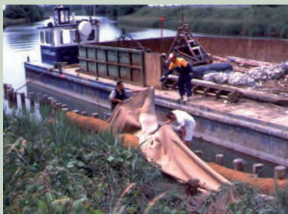
Fig. 12: Consolidamento con tronchi, rulli di cocco, geotessuti e fibre miste, abbinati a fascine di tamerice (fiume Natissa, Laguna di Grado GO)
