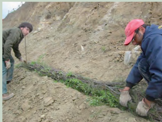
Figg. 42 e 43: Realizzazione di fascine vive di tamerici e messa a dimora di arbusti mediterranei, aprile 2007 (Foto Paolo Cornellini)
