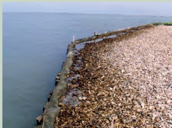
Fig. 17 e 18: Ricostruzione di barene con fanghi di dragaggio; contenimento con pali e geotessuti in località La Vallona – Po di Levante (RO)
