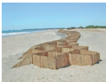
Fig. 9.15: Strutture frangivento sulla morfologia dunale ricostruita
