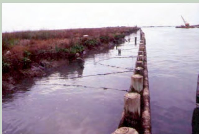
Fig. 10 e 11: Prove, scarsamente efficaci, di consolidamento in tronchi e tavole tirantati, con messa a dimora di tamerici per lo stoccaggio di fanghi di drenaggio di canali lagunari (Laguna di Grado, GO, e di Marano, UD) (Foto Giuliano Sauli)
