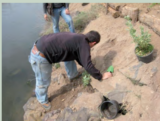
Figg. 33 e 34: Realizzazione di palificate vive spondali e trapianto di specie arbustive autoctone (Foto Paolo Cornelini)
