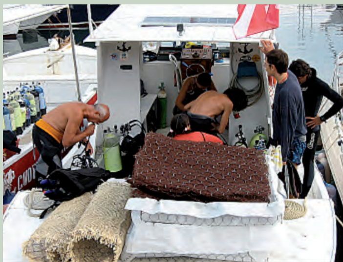
Fig. 3: Trasporto in mare dei sistemi antiersosivi (Foto da F. Boccalaro, 2006)
