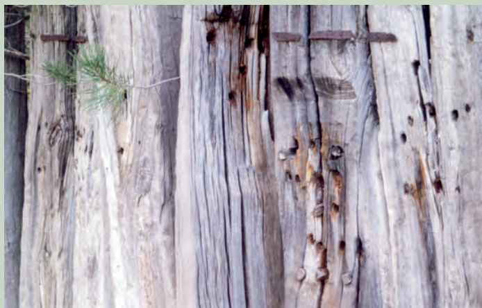
Fig. 2: Particolare delle traverse ferroviarie di legno, ormai consunte, infisse 130 anni fa nella duna di Balestrate (PA) per consolidarla e rimboschirla allo scopo di rendere sicura la ferrovia Palermo-Trapani che vi fu costruita sopra. Le traversine erano distanziate di 2 - 3 cm e rese solidali mediante nastri di lamierino di cui sono ancora visibili i resti arrugginiti (Foto Salvatore Puglisi, 2007)
