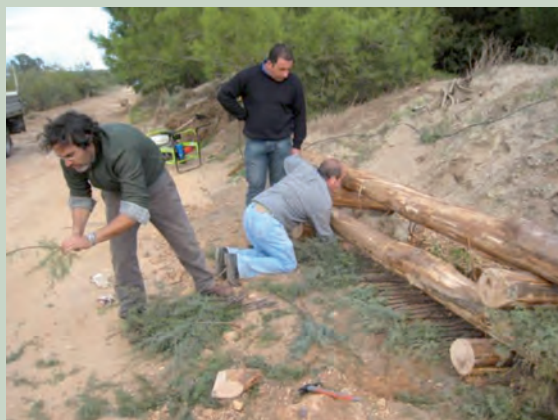
Fig. 31: Scarpata sabbiosa in erosione con inserimento di talee di tamerice
