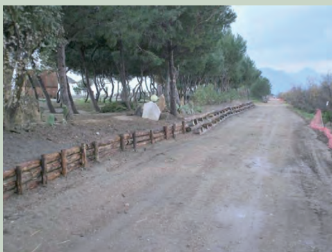
Fig. 32: Palificate e palizzate di consolidamento lungo un'infrastruttura viaria
