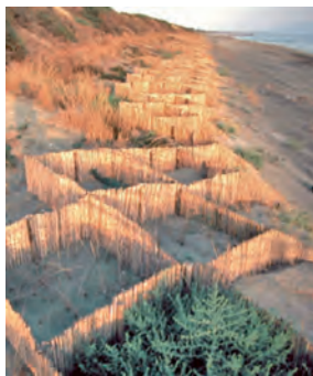
Fig. 9.11: Sistemi frangivento "a scacchiera"
