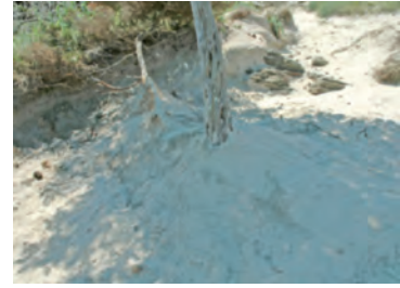
Fig. 9.22 e 9.23: Ricoprimento delle radici con sabbia e foglie di Posidonia e successiva protezione con biostuoia in cocco
