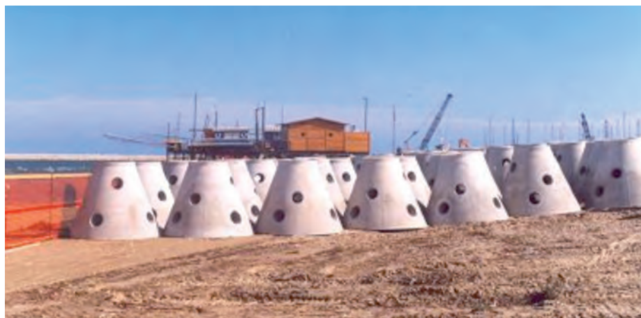
Fig. 11.12: Campane in calcestruzzo depositate sulla spiaggia di Pescara prima di essere caricate sul pontone (Foto Carla Giansante)
