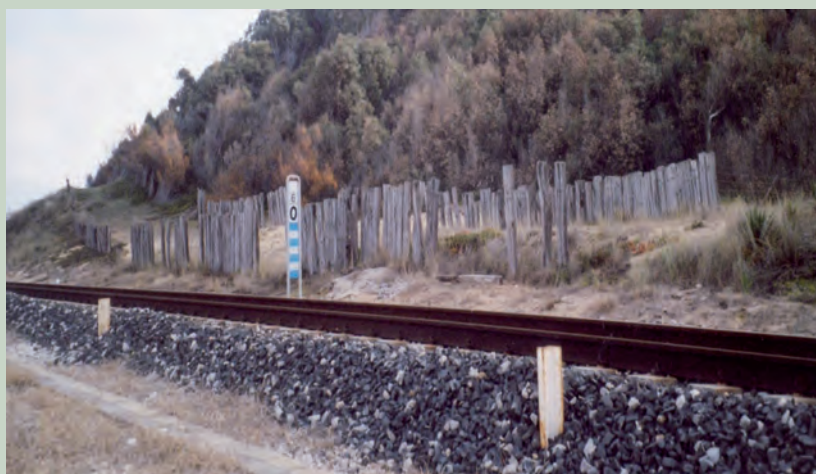
Fig. 9: Nel rimboschimento della duna di Balestrate (PA) sono ancora visibili le traverse ferroviarie a suo tempo infisse nella sabbia per stabilizzarla e rendere possibile la piantagione di specie arboree (Foto Salvatore Puglisi, 2007)
