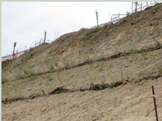
Figg. 42 e 43: Realizzazione di fascine vive di tamerici e messa a dimora di arbusti mediterranei, aprile 2007 (Foto Paolo Cornellini)
