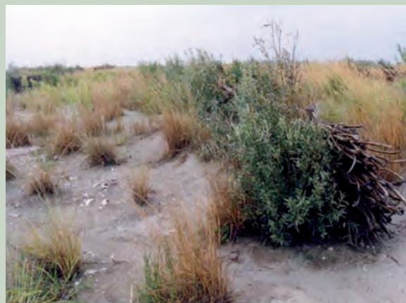
Fig. 19 e 20: Stabilizzazione di cordoni dunali mediante graticciate e trapianti di cespi di Ammophila arenaria e graticci con legno morto e vivo di Salix alba , in località La Vallona – Po di Levante (RO)
