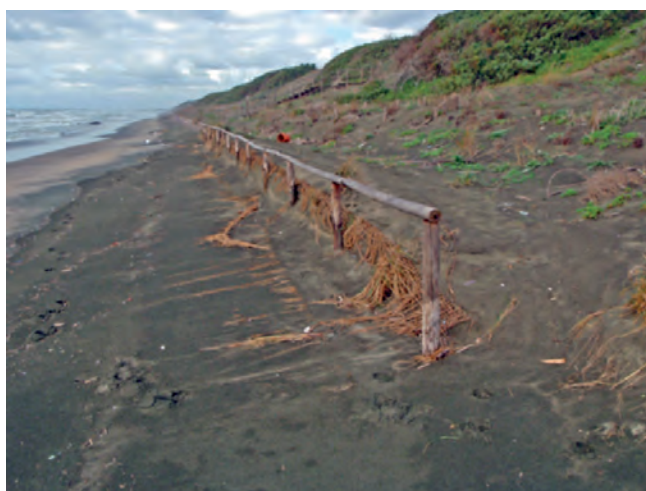
Fig. 4.7 Demolizione parziale di una foredune formata per effetto di un frangivento, nel Parco Nazionale del Circeo (Foto Giancarlo Bovina)
