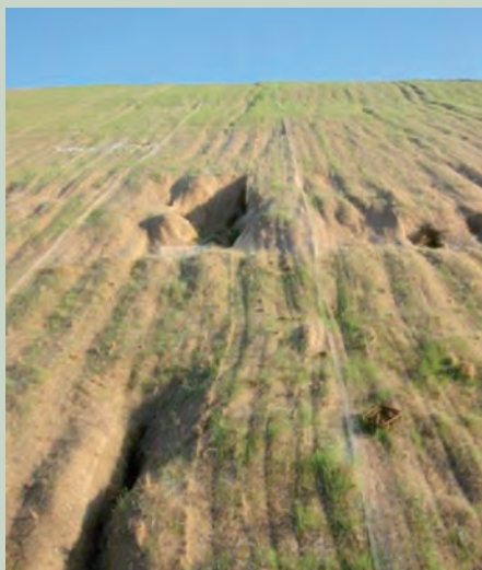
Figg. 40 e 41: Scarpate artificiali su terreni sabbiosi con evidenti fenomeni erosivi nonostante l'impiego di biostuoie inerbite
