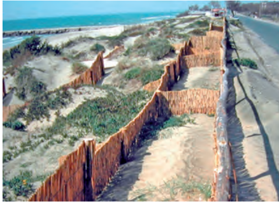
Fig. 9.9: Recinzione dissuasiva e associato schermo frangivento
