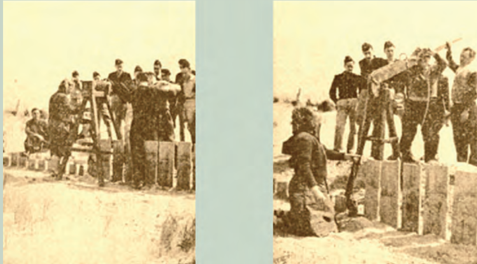
Fig. 4: Il dispositivo per estrarre dalla duna litoranea le assi della palizzata sepolte dalla sabbia ha trovato ancora impiego nel secolo XX (Foto Silvy-Leligois, 1963)
