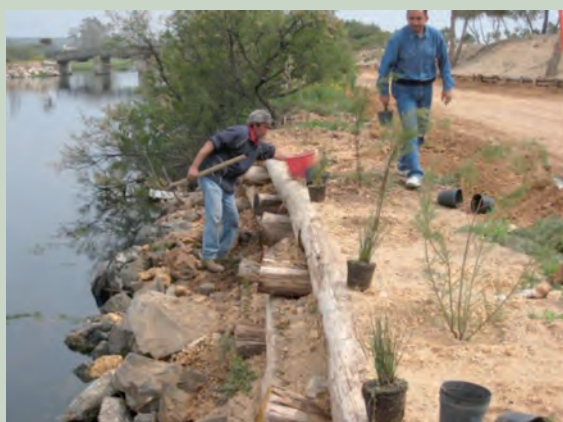
Figg. 33 e 34: Realizzazione di palificate vive spondali e trapianto di specie arbustive autoctone (Foto Paolo Cornelini)
