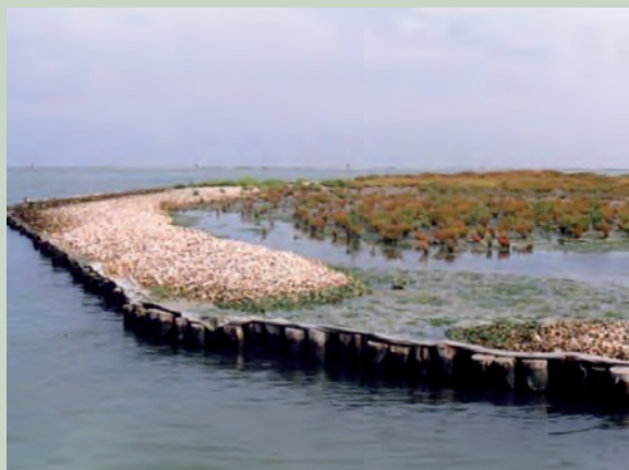
Fig. 17 e 18: Ricostruzione di barene con fanghi di dragaggio; contenimento con pali e geotessuti in località La Vallona – Po di Levante (RO)
