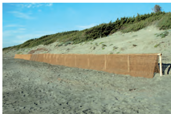
Fig. 9.18: Frangivento in biostuoia di cocco
