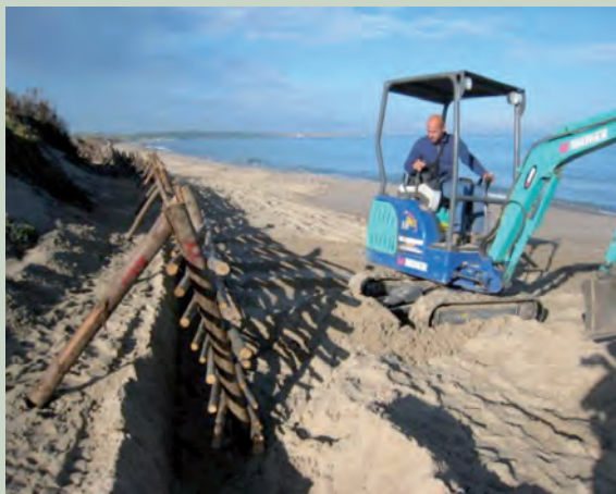
Fig. 36: Realizzazione delle graticciate
