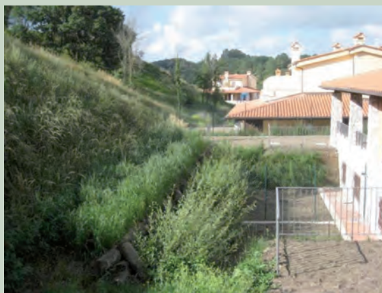
Figg. 45, 46 e 47: Realizzazione di palizzate in tronchi orizzontali, palificate vive con arbusti mediterranei, al piede delle scarpate attigue alle residenze (Foto Paolo Cornelini)
