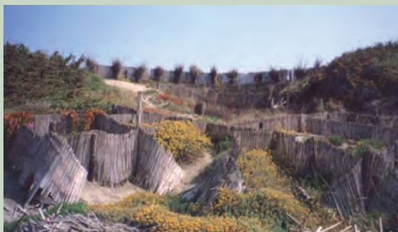
Fig. 50: Parco Nazionale del Circeo, aprile 2003, resti delle graticciate utilizzate per intrappolare la sabbia e limitare l'erosione delle dune costiere.
