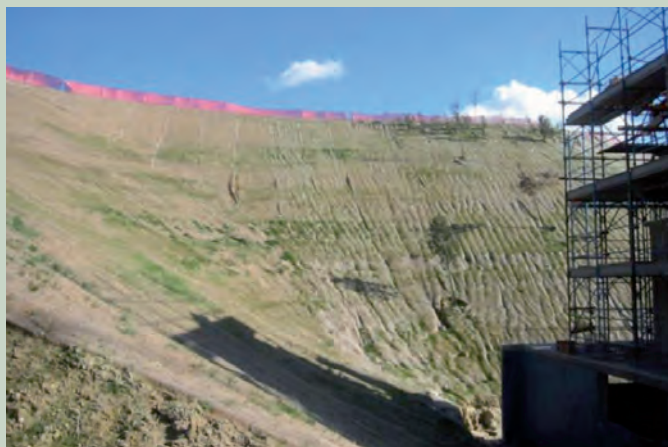
Figg. 40 e 41: Scarpate artificiali su terreni sabbiosi con evidenti fenomeni erosivi nonostante l'impiego di biostuoie inerbite
