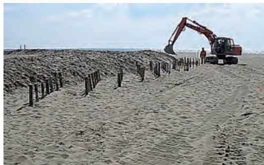
Installazione fascinate per restauro dunale a fine sentiero
