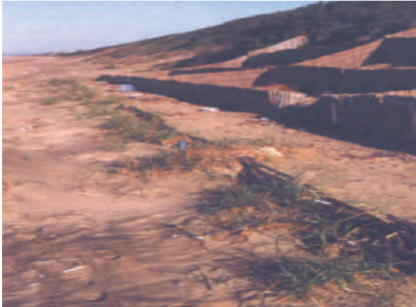
Effetti delle mareggiate degli anni '80, con demolizione parziale della duna e strada costiera (Foto Giancarlo Bovina, 2003)
