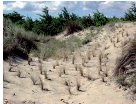
Palizzata di sostegno e rinverdimento dei cumuli sabbiosi (Foto Tecnovia s.r.l.)
