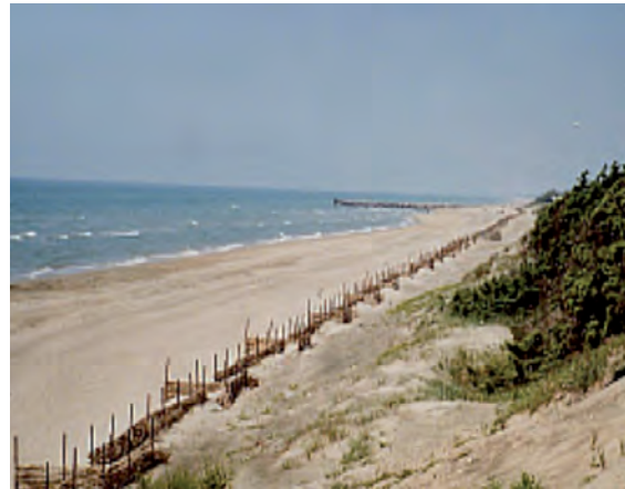
Opere di contenimento e consolidamento delle sabbie (Foto Salvatore Puglisi, 2000)
