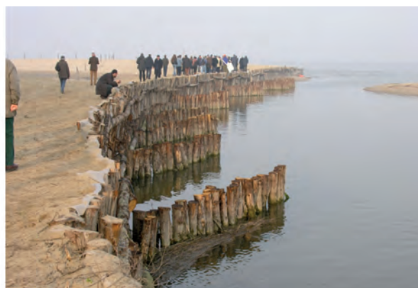
Protezione lato nord nuova foce con palificazione in legno di castagno tirantata
