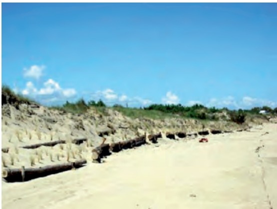
Palizzata di sostegno e rinverdimento dei cumuli sabbiosi (Foto Tecnovia s.r.l.)
