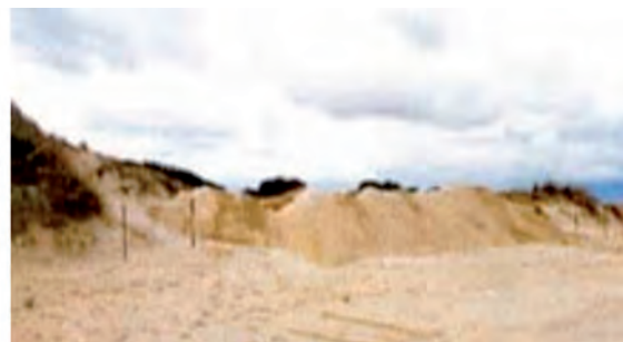
Modellamento del corpo dunale con materiale recuperato in sito
