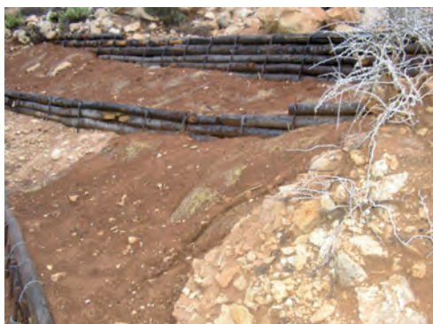
Palizzate per fini antierosivi e per la successiva reintroduzione di piante (Foto Giuseppe Messina - aprile 2006)
