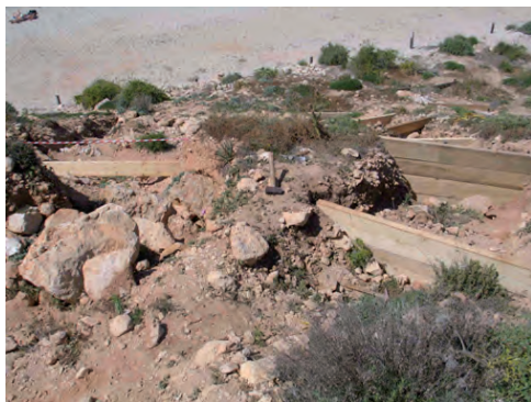
Steccati e palizzate per la riconfigurazione morfologica dei solchi di erosione (Foto Gino Menegazzi - 2006)
