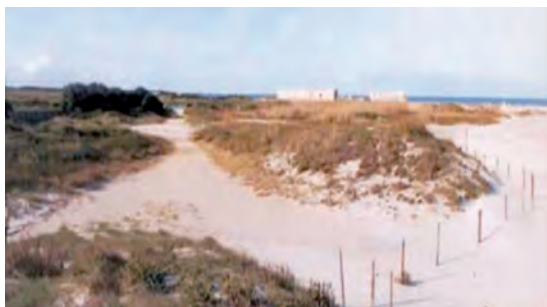
Modellamento del corpo dunale con materiale recuperato in sito
