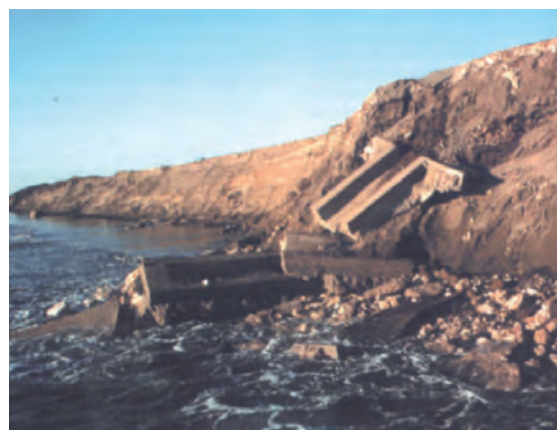
Barriera basale a 5 anni dalla realizzazione: evidenti sono la deposizione di sabbia e la formazione di una duna embrionale (Foto Giancarlo Bovina, 2003)
