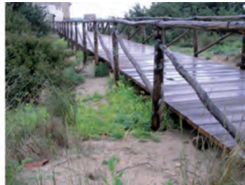
Passerella di attraversamento
