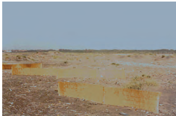
Le barriere frangivento per intercettare la sabbia
