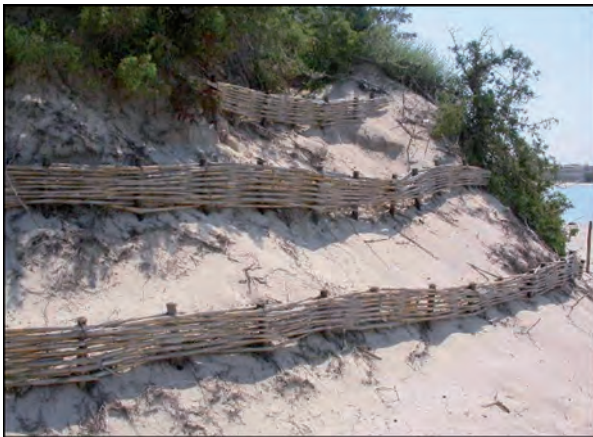
Consolidamento della scarpata dunale con viminate di materiale vegetale locale
