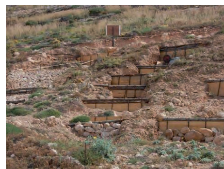
Palizzate per fini antierosivi e per la successiva reintroduzione di piante (Foto Giuseppe Messina - aprile 2006)
