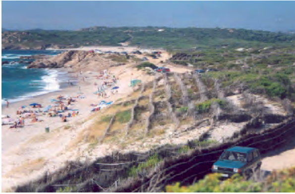
Barriere frangivento in legno (vista lato mare) installate per intercettare la sabbia e proteggere la duna dal calpestio (Foto F. Converio, 2002)
