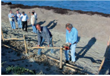
Lavori per la realizzazione della recinzione in legno a protezione del cordone dunale
