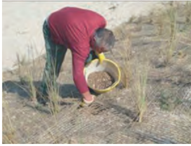
L'impianto delle specie con biostuoie
