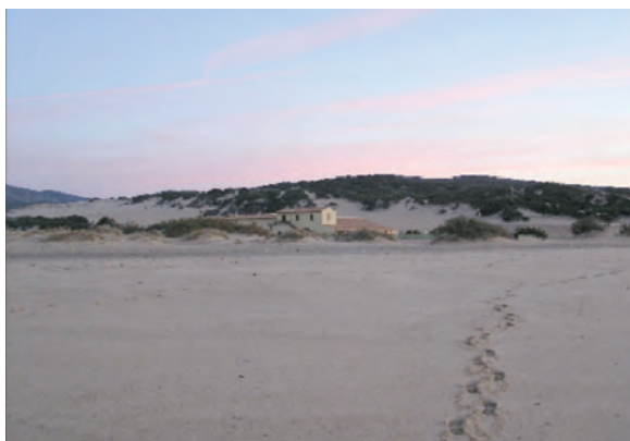
Una struttura alberghiera sull'habitat prioritario delle dune stabilizzate
