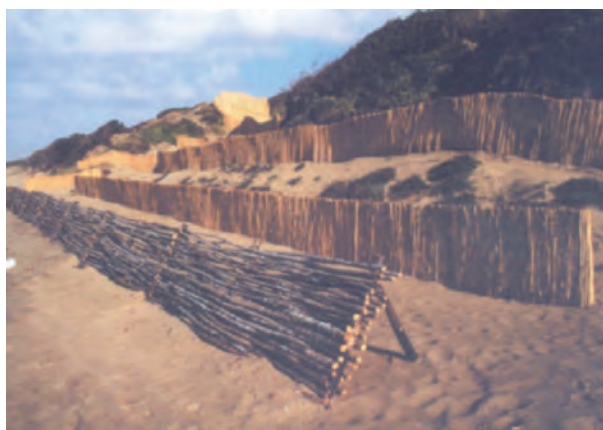
Barriera basale in viminata subito dopo la sua realizzazione (Foto Giancarlo Bovina, 2003)
