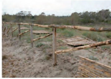
Avanzamento dei lavori della recinzione a protezione del cordone dunale
