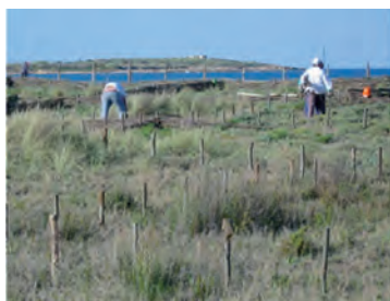
Inizio dei lavori per la realizzazione delle barriere frangivento
