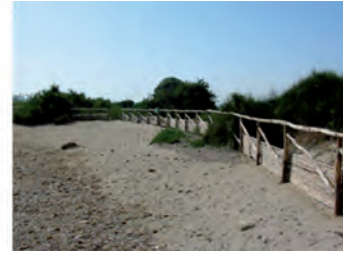
Recinzione in legno realizzata
