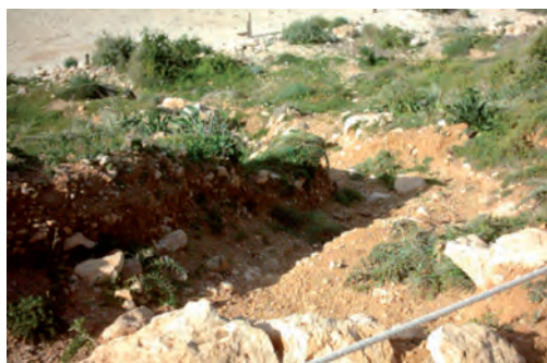
Fosso di erosione oggetto di intervento di ripristino (Foto Gino Menegazzi - 2006)
