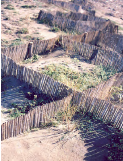
Schermi frangivento disposti a scacchiera, a circa 4 anni dalla loro realizzazione (Foto Fabio Converio, 2003)
