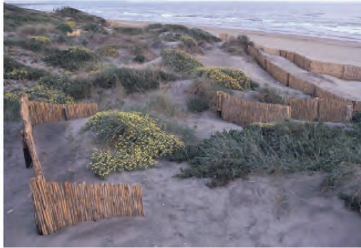
Barriera basale in viminata realizzata in prossimità della linea di riva (Foto G. Marcoaldi, in: "Il bilancio di LIFE Natura in Italia. Indicazioni e prospettive per il futuro")
