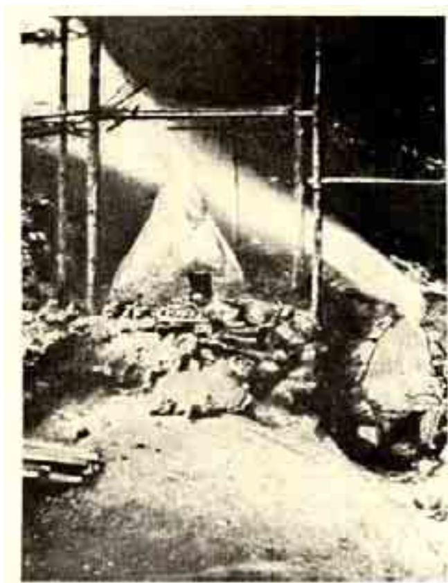
Fig. 39 _ Forni a catasta per fabbricazione della spugna di ferro, di tipo libero e tipo seminterrato, in uso all'epoca etrusca.
