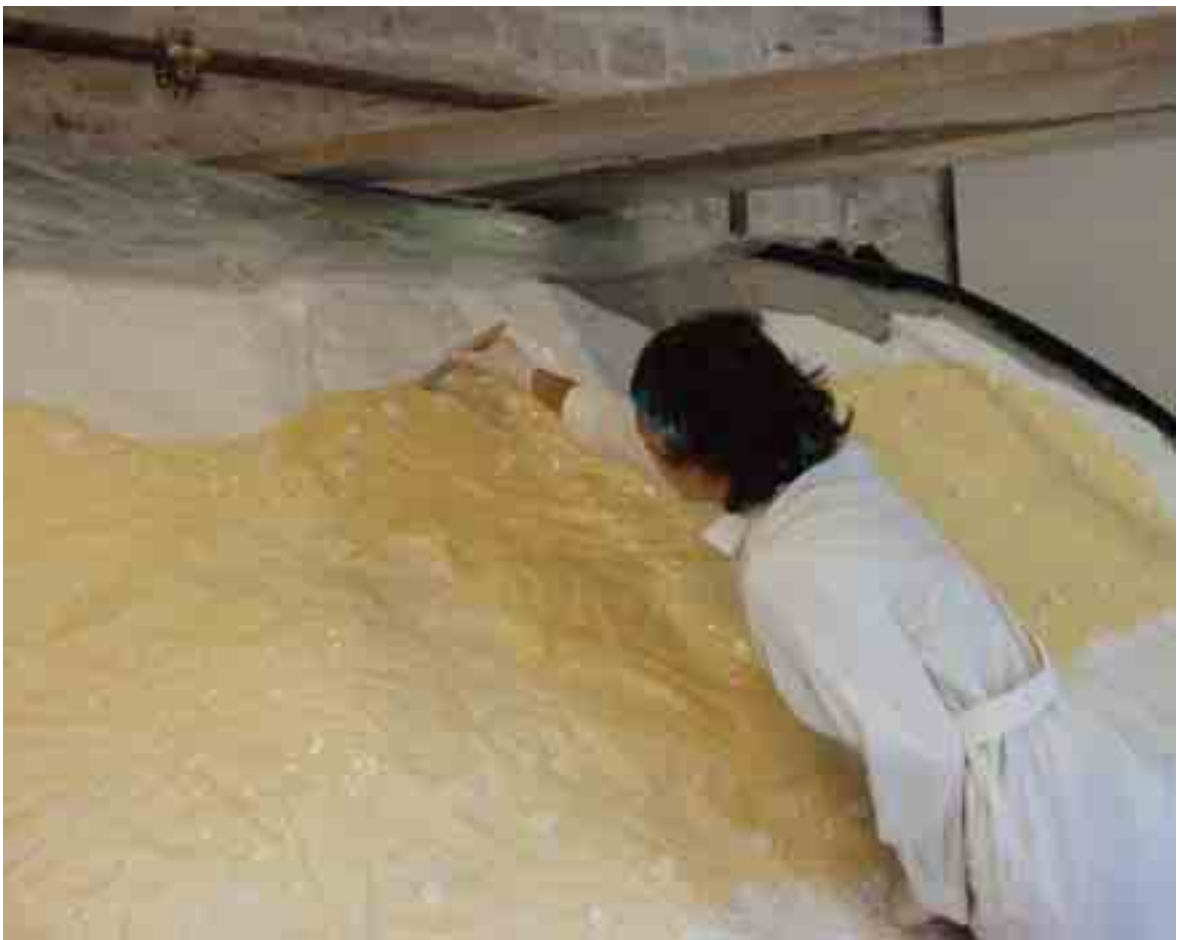
Fig. 22 – Quinta mano di elastomero colorato con tonalità più scure di giallo.
