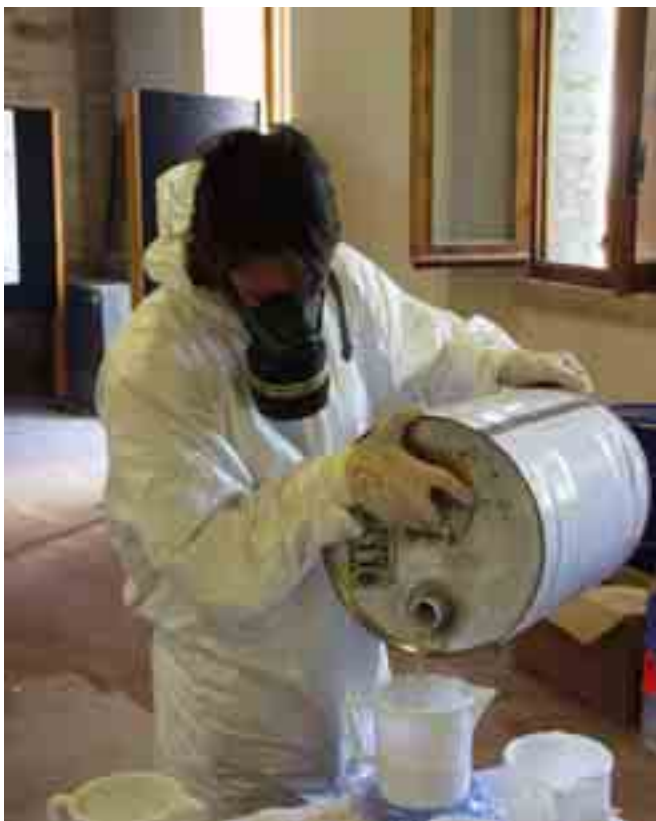
Fig. 26 – Preparazione della resina in piccole quantità. Il materiale viene sempre accuratamente pesato con una bilancia di precisione.
