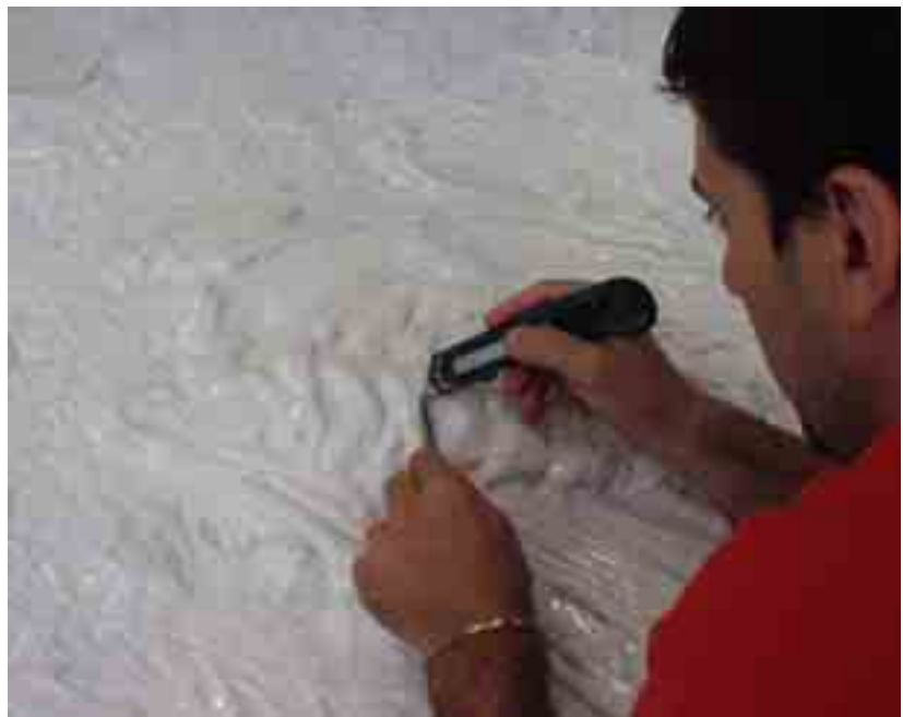
Fig. 18 – Individuazione delle bolle d'aria e loro apertura.
