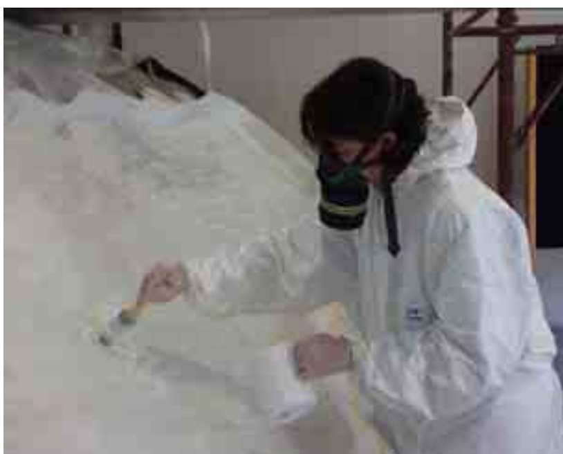
Fig. 27 – Prima mano di resina poliestere.
