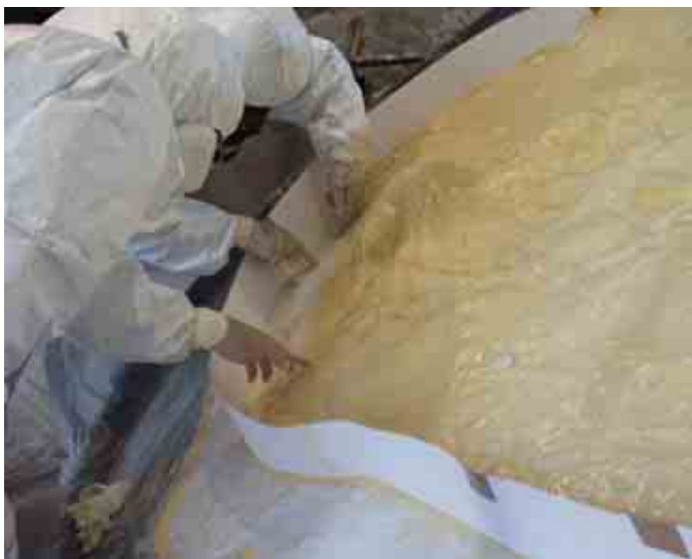
Fig. 25 – Sia la preparazione della lana di vetro, sia la sua messa in posto e la successiva impregnazione con la resina devono essere effettuate con estrema cautela e seguendo norme di sicurezza definite .
