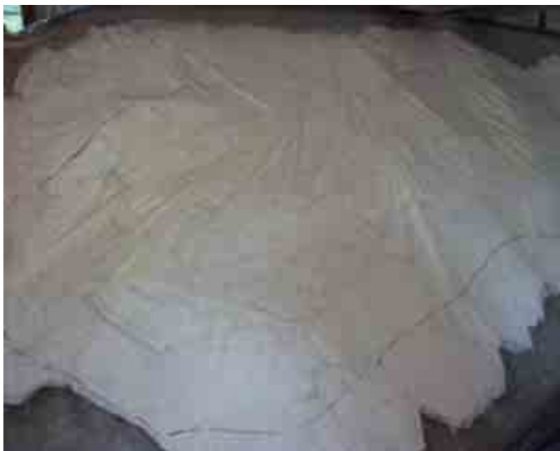
Fig. 19 – La pellicola di riferimento viene riposizionata per individuare l'area su cui passare la terza mano di elastomero.
