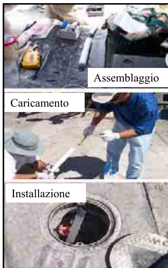
Figura 11.3- Installazione del MICRO-Trac (da WRSC 2006).
