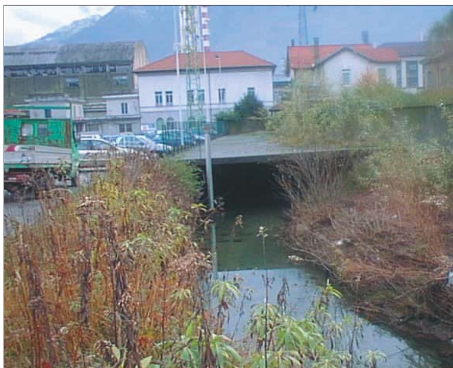
Foto 10-2: Torrente Marmazza. Sezione di ingresso nel tratto tombato, a monte dello stabilimento EniChem (visibile sullo sfondo).
