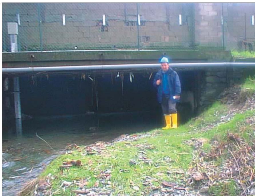
Foto 10-1: Torrente Marmazza. Sezione di uscita dal tratto tombato, a valle dello stabilimento EniChem. Si notano resti vegetali depositi dalla piena sino a pochi centimetri dalla volta, a testimonianza del quasi raggiungimento del massimo volume di deflusso consentito.
