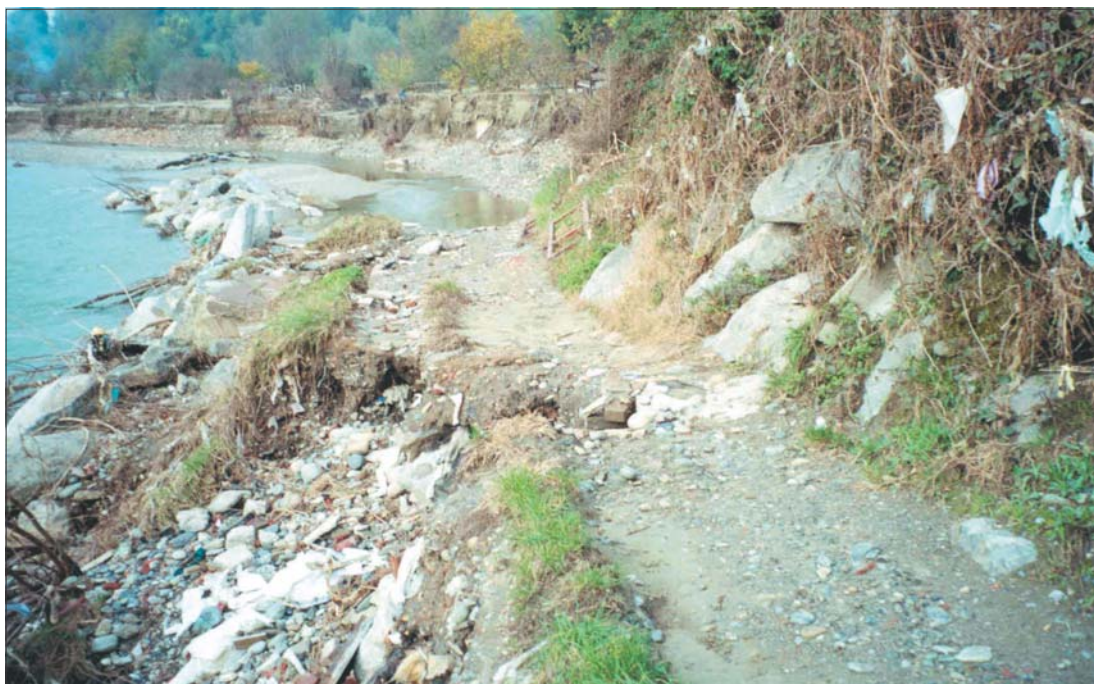
Foto 6-1: Stradina d'accesso Orti sponda sinistra del T. Stura di Lanzo. I fenomeni erosivi hanno asportato parte dei terreni alluvionali, distrutto la scogliera di protezione e la stradina sterrata, inducendo instabilità della scarpata in prossimità della strada d'accesso alla discarica.
