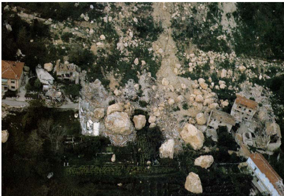
Figura 11.19 Fotografia storica di un crollo avvenuto durante il terremoto del 6 maggio 1976 (Frazione di Braulins-Comune di Gemona del Friuli, Provincia di Udine).
