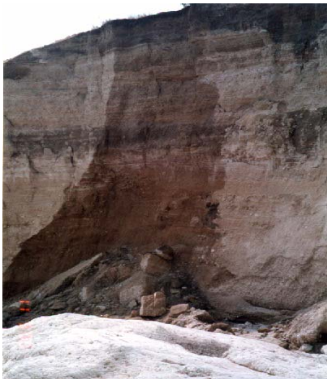
Figura 21.4 Frana da crollo nella falesia presso Mattinata (foto U. Guerra).
