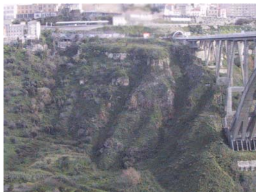
Figura 23.34 Catanzaro - Ampia zona franosa con movimenti complessi costituiti da frane nel substrato cristallino-metamorfico alterato che si evolvono in colata rapida di detrito/terra, a cui si associano fenomeni di crollo/ribaltamento e scorrimenti di blocchi di roccia nella sovrastante placca di sedimenti miocenici.
