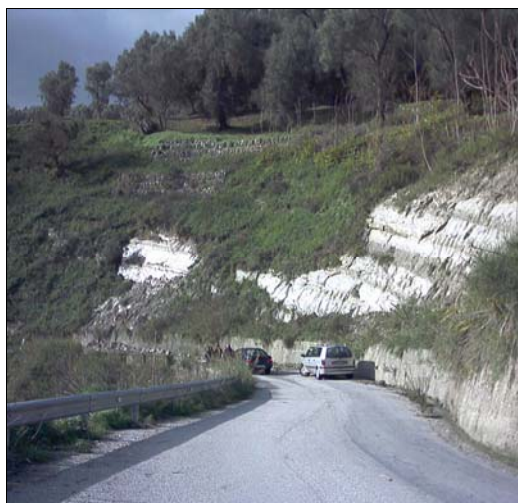
Figura 23.27 S.P. Palmi San Procopio (Ponte Mangano). Parete sub-verticale costituita da alternanze argilloso-marnose (con intercalazioni sabbiose), interessata da caduta di blocchi e colamenti, per episodi successivi, che arrivano ad ostruire periodicamente la sede stradale.
