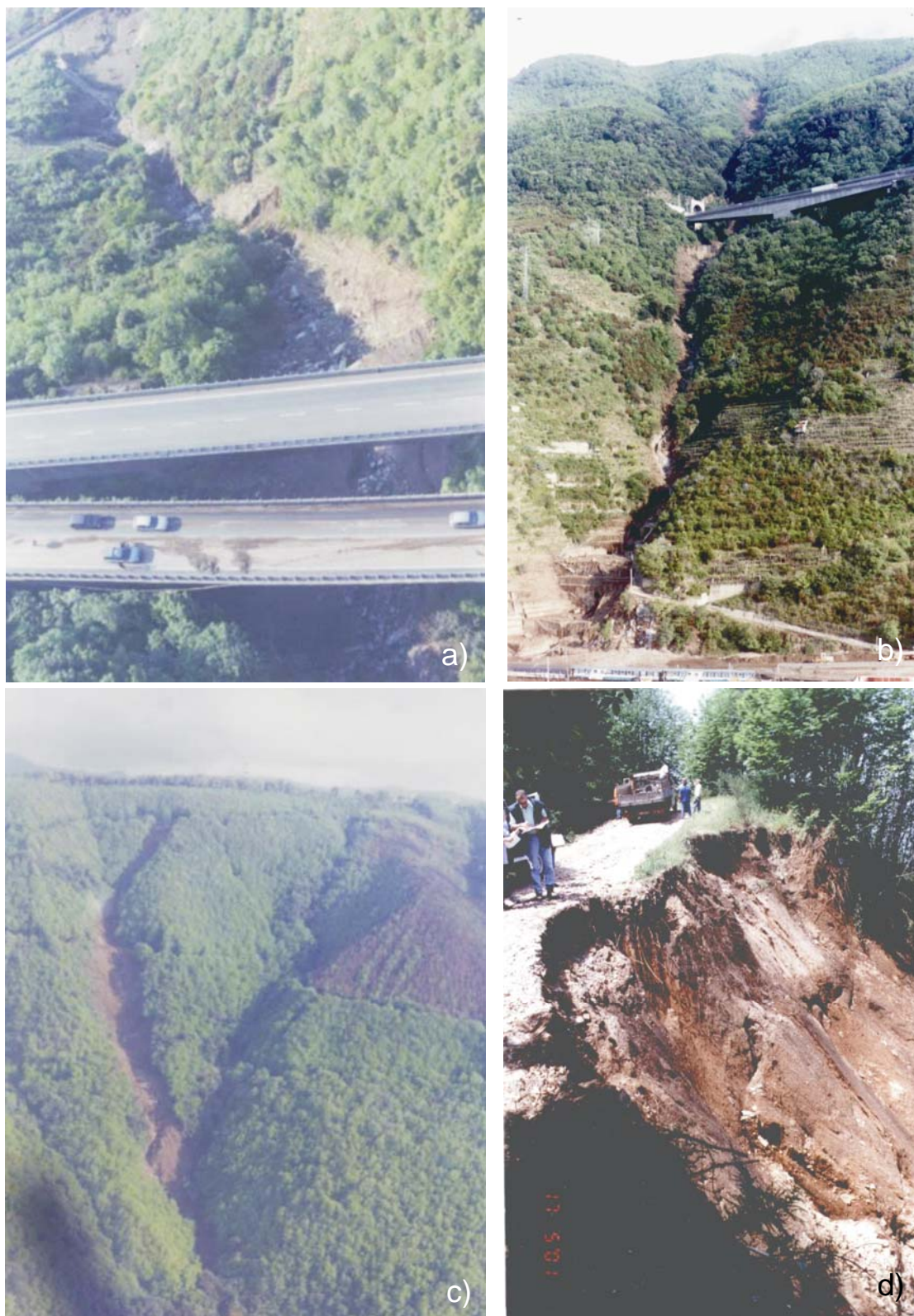
Figura 23.15 Fenomeno di colata rapida, misto a torrente di detrito, che ha interessato il Vallone Favagrega ubicato lungo il costone tra Scilla e Bagnara (RC - maggio 2001; Archivio ABR). a) Colata di detrito nel tratto medio-inferiore del Vallone Favagrega. Si osservi che l'ondata di fango ha raggiunto anche la corsia Nord dell'autostrada A3. b) Canalone Favagrega: percorso dalla colata di fango e detriti nel tratto medio-inferiore. c) Testate dei due canali meridionali del Vallone Fava Greca in cui si sono innescati i fenomeni franosi. d) Nicchia di distacco della frana principale. E' evidente la presenza di materiale in condizioni di incipiente collasso. Tali fenomeni sono ampiamente diffusi nell'area e coinvolgono principalmente le coltri di alterazione del substrato cristallino-metamorfico.
