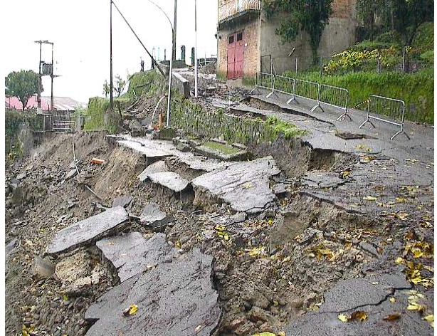
Figura 23.30 Esteso fenomeno franoso rotazionale nell'abitato di Sinopoli Inferiore (RC).
