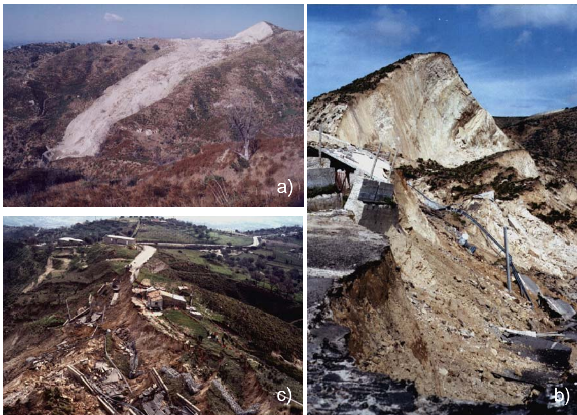
Figura 23.14 Gioiosa Ionica (RC) - M. Linarè (febbraio 2001): a) fenomeno franoso roto-traslattivo di vaste dimensioni verificatosi nei depositi sedimentari miocenici. b) particolare della zona di coronamento e della scarpata di frana; c) fianco destro della frana in cui risaltano l'entità del danno provocato (distruzione completa della SP) e le vaste proporzioni del fenomeno, i cui effetti sono evidenti anche al di là della linea spartiacque grazie alle estese zone di detensionamento e di fratturazione.
