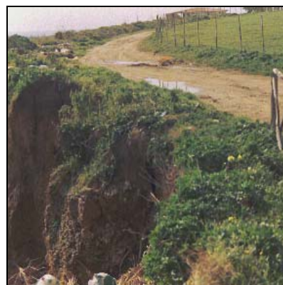
Figura 23.25 Isola Capo Rizzuto (KR)- Località Le Cannella: esempio di attivazione di fenomeni franosi per crollo a seguito di forti mareggiate, con distacco del tratto di costa alta (Falesie) e conseguente smottamento del manto stradale e rischio per le abitazioni a monte.
