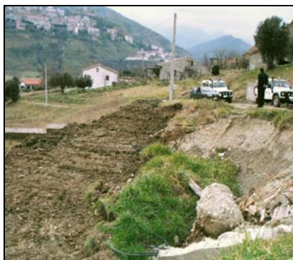
Figura 23.23 Malvito (CS) - Strada Roncino - Boiano: numerosi fenomeni franosi per scorrimento-colata e/o colata che interessano il tracciato dell'Acquedotto ABATEMARCO.
