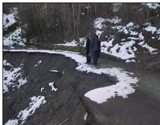
Figura 23.21 Conflenti (CZ)-Loc. Passo del Ceraso: la strada comunale è stata interessata da un vasto fenomeno franoso per scorrimento che ha coinvolto la carreggiata. Il fenomeno si è sviluppato nelle metamorfiti di basso grado da mediamente ad altamente alterate.
