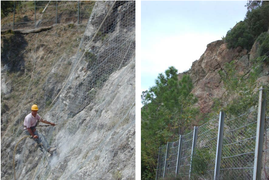
Figura 3.30 a) Messa in opera di rete paramassi a doppia torsione ancorata con chiodature e rinforzata con funi in trefoli d'acciaio incrociate, Cetara (SA); b) Barriera paramassi statica, Levanto (SP).
