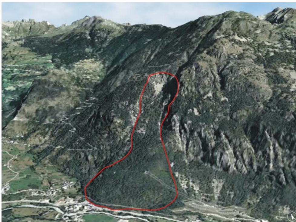
Figura 6.14 Esempio di frana di crollo (La Salle, PIFF 007-30924-00).
