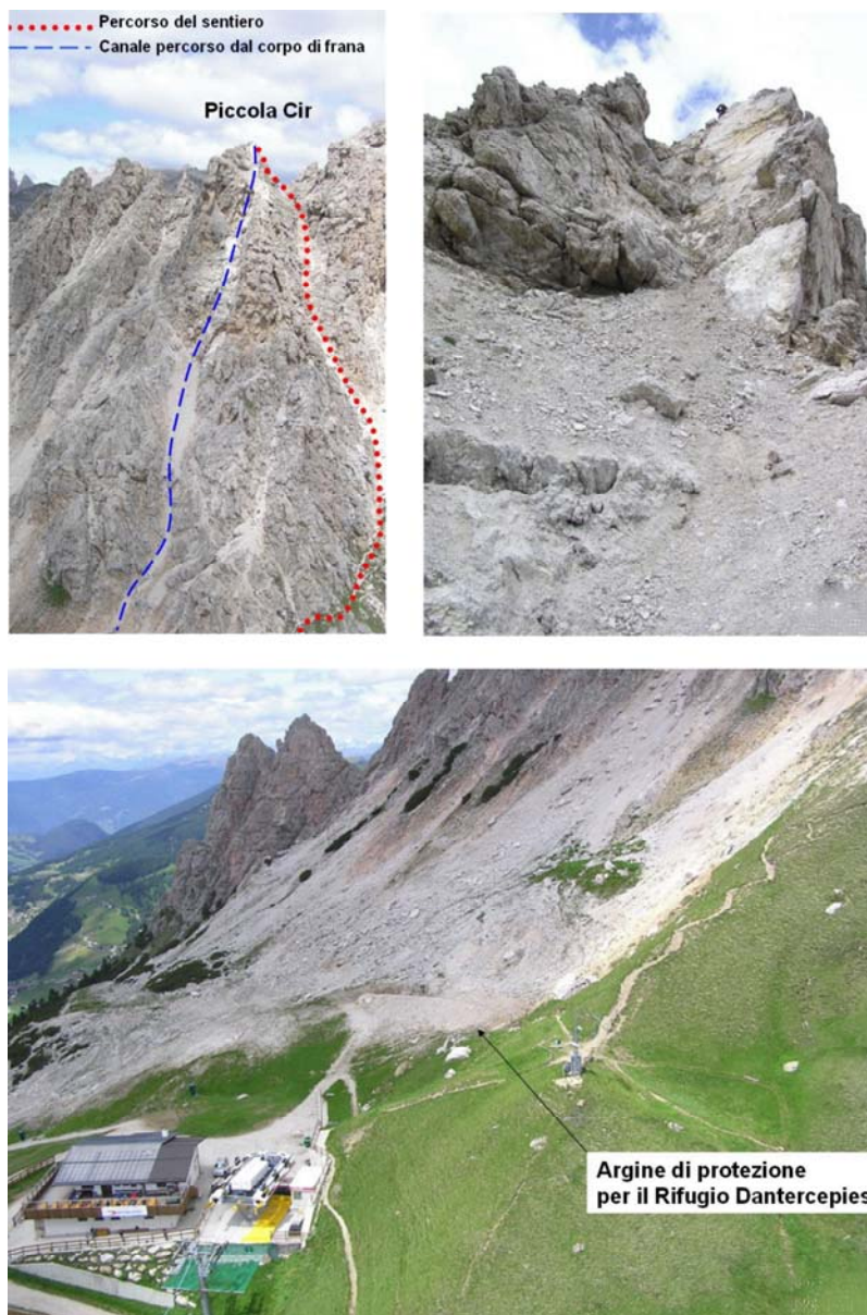
Figura 8.14 a) Percorso del sentiero (rosso) e canale percorso dal corpo di frana (blu); b) Nicchia di distacco sulla Cima piccola Cir; c) Argine di protezione per il rifugio.
