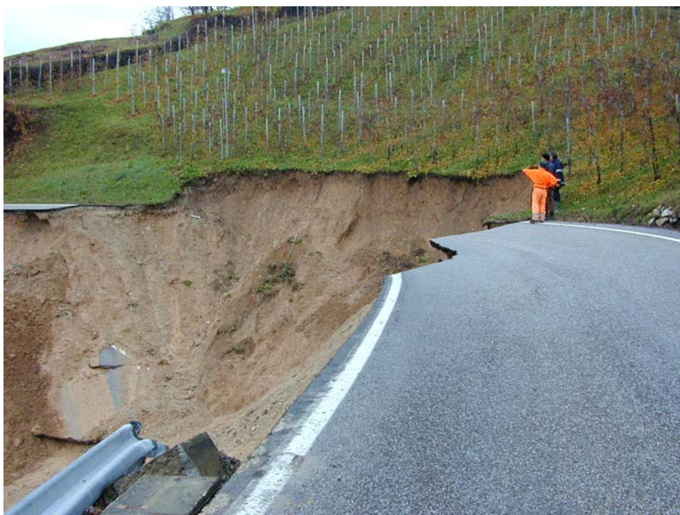
Figura 9.10 Frana per scivolamento rotazionale (Val di Non).
