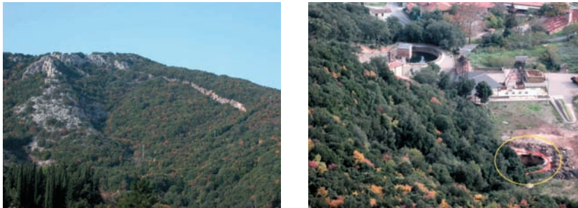
Fig. 5: Galleria (-20) collassata(a sinistra), crollo in galleria (a destra).
