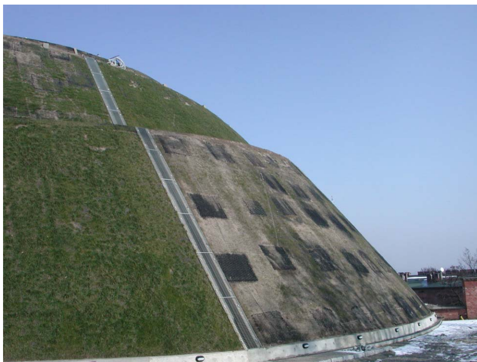
Esempio di struttura di geostuoia rinforzata con rete a doppia torsione
