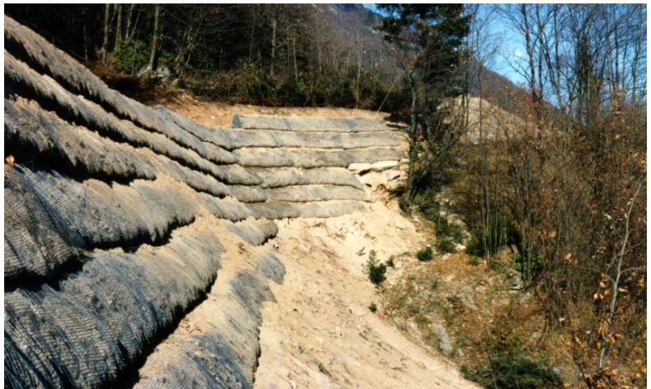
Fase di realizzazione di un rilevato paramassi in terre rinforzate con geosintetici in ambiente montano.
