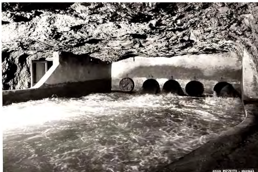
Figura 5: I cinque tubi di mandata della grande galleria di scolo di Monteponi.
