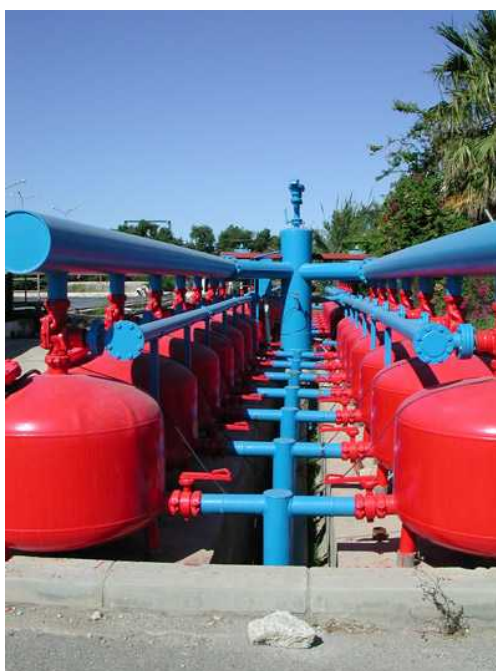
Foto 2.4 – Sistema di filtri a sabbia
