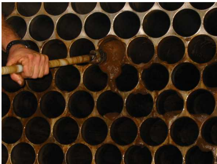
Foto 2.9 – Fango che ostruisce l’impianto di produzione Ozono
