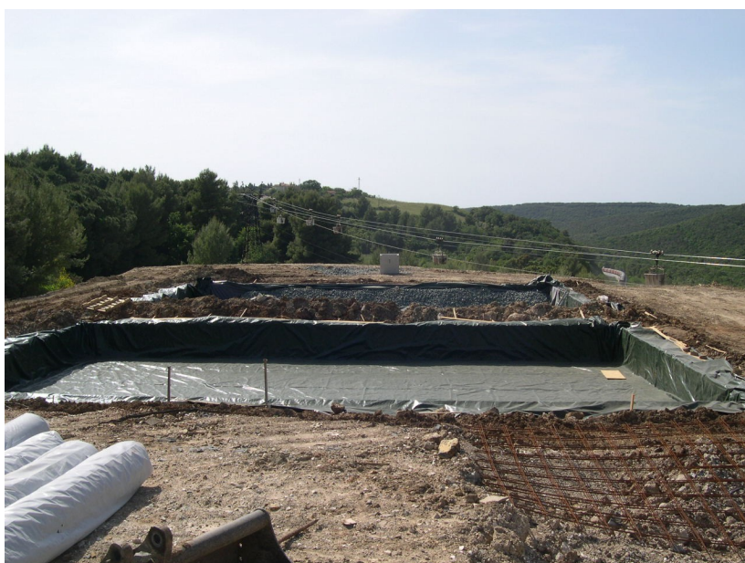
Figura 7 – Fasi di realizzazione vasche a flusso orizzontale
