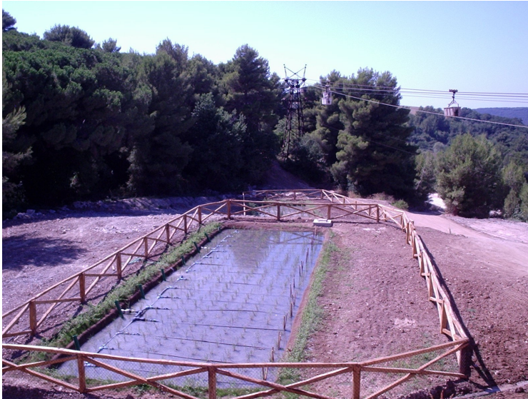
Figura 11 – Vasche a flusso verticale a lavori ultimati (luglio 2008)
