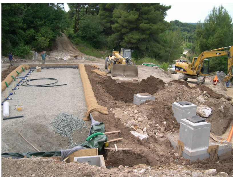
Figura 8 – Particolari di vasca a flusso verticale e stazione di sollevamento
