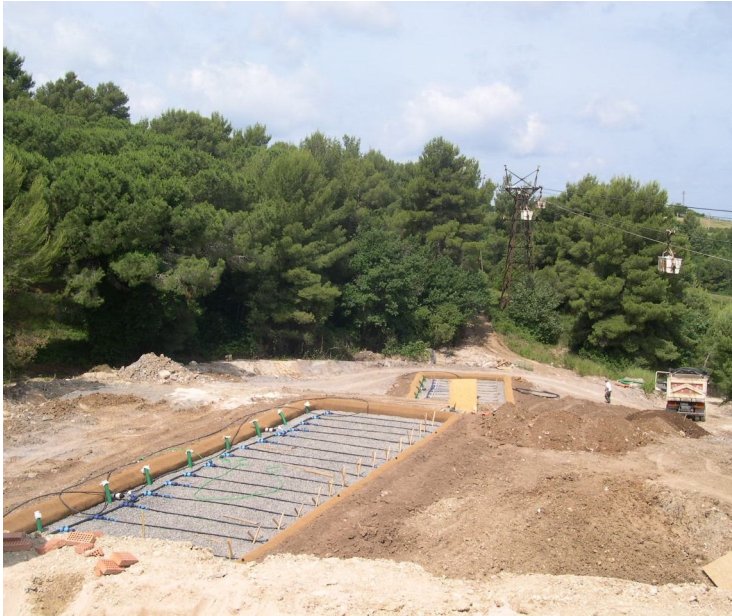
Figura 9 – Vasche a flusso verticale prima dell'inserimento delle specie vegetali (giugno 2008)
