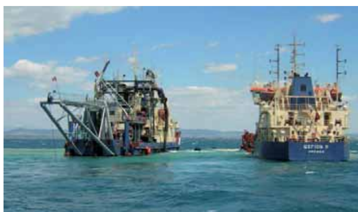
Figura 9.4: Alcune fasi del dragaggio di sabbie relitte al largo di Montalto di Castro (Lazio) 9
