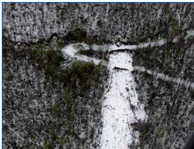
Figura 7.18: Fattori predisponenti antropici - Scivolamento traslativo evolvente a colata innescatosi in corrispondenza di un tornante di una strada forestale, Cervinara (AV) 15/12/1999 19
