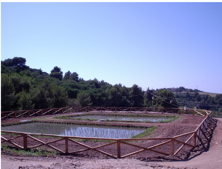
Figura 10 – Vasche a flusso orizzontale a lavori ultimati (luglio 2008)
