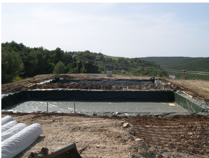
Figura 7 – Fasi di realizzazione vasche a flusso orizzontale
