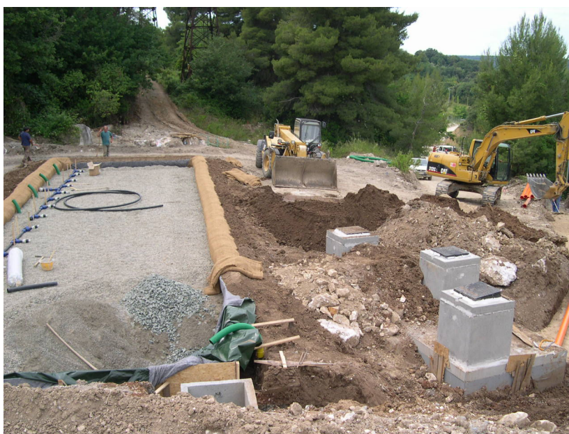
Figura 8 – Particolari di vasca a flusso verticale e stazione di sollevamento
