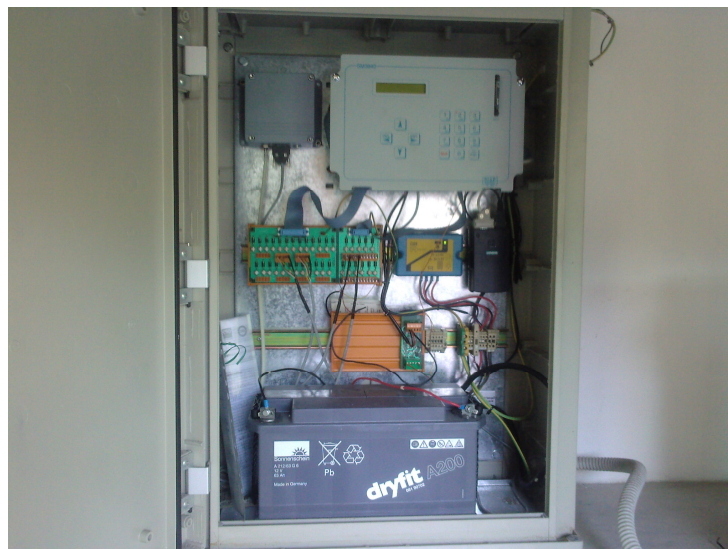
Figura 3.2: Componenti della Stazione Mareografica
