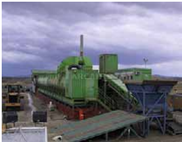
Tramoggia e forno di desorbimento
