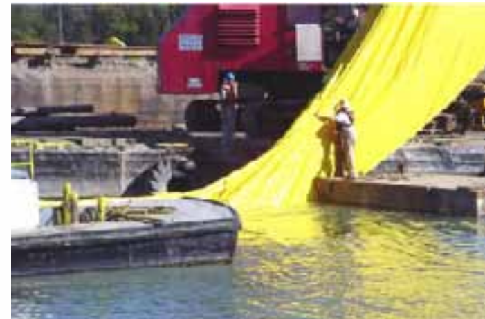
Installazione di barriere
