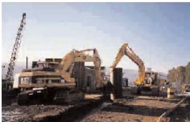
Fig. C3. Inserimento di tubi filtro
