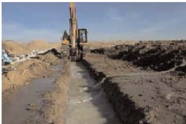
Fig. C2. Esecuzione di uno scavo per trincea
